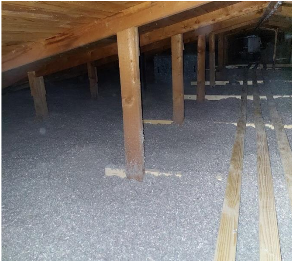
Bild 2. Färdig isolering med landgång.
