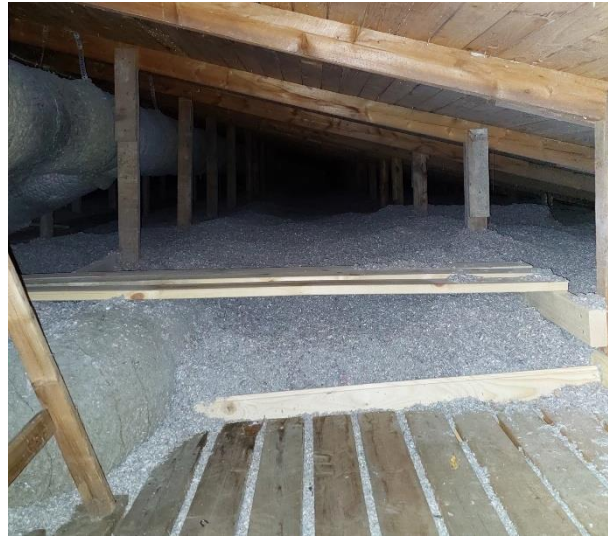
Bild 3. Färdig isolering med serviceplattform.
