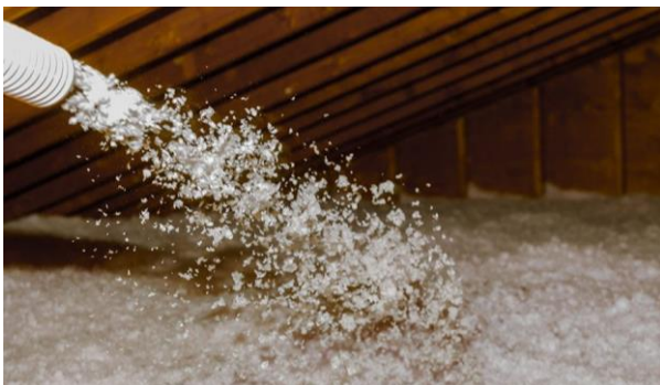
Bild 4. Isolering sprutas in på vind (hämtad bild).
