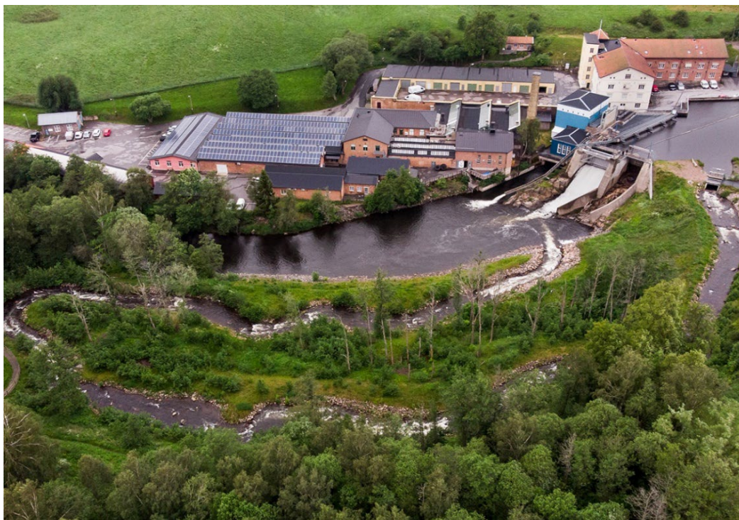
Figur 3. Hedefors vattenkraftverk, Lerums kommun. Konstruktion av naturligt omlöp för att gynna svagsimmande arter. Projektet har fått finansiering av Bra Miljöval Miljöfond.
