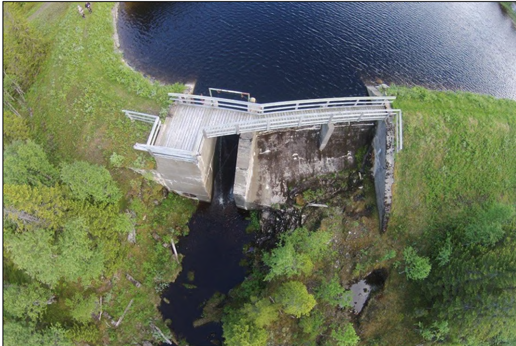
Figur 3. Bilden visar utskovsdelen, de båda ytvattenutskoven till höger i bild och bottenutskovet till vänster i bilden.
