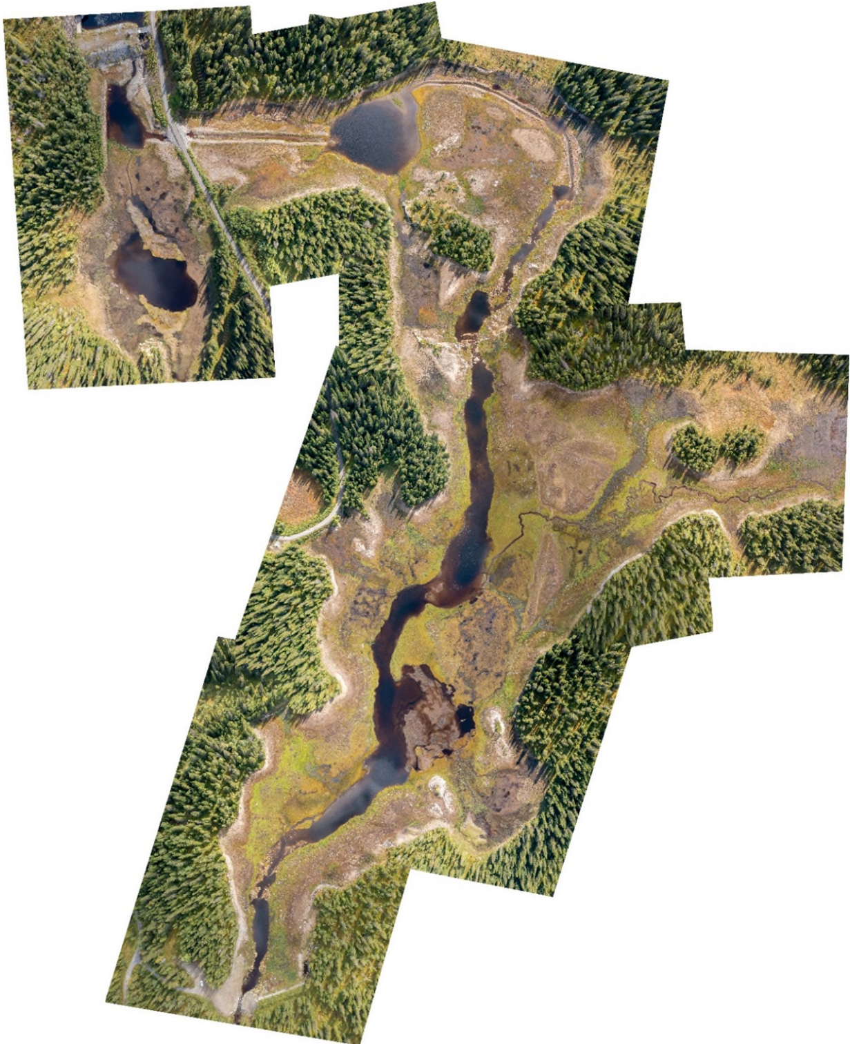
Figur 5. Flygbilden visar det tömda magasinet i augusti 2024. Dammläget längst ned i bilden
