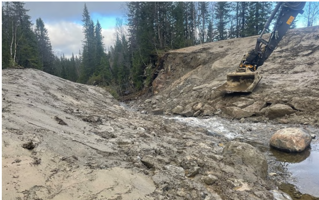
Figur 5. Fotografiet visar anläggandet av erosionskyddet i läget för den tidigare utskovsdelen. Den vertikala delen i mitten av bilden är den kvarstående bergskärningen. Fotot är taget i oktober 2023.
