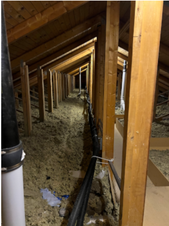
Rördragning på vinden
