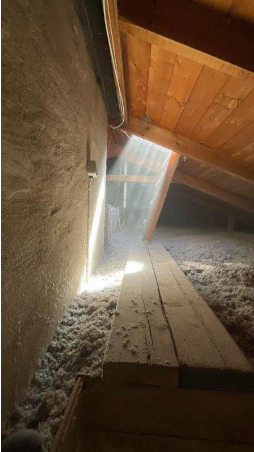
Tilläggsisolering med 400mm cellulosa
