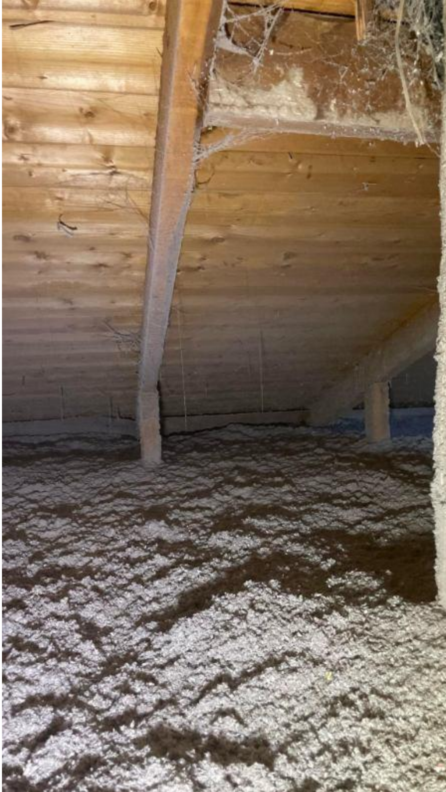
Tilläggsisolering med 400mm cellulosa
