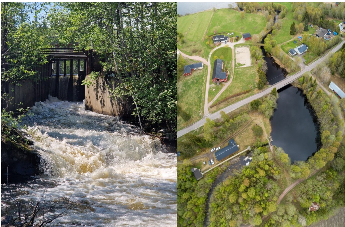
Före åtgärd, vandringshinder och indämda sträckor.
