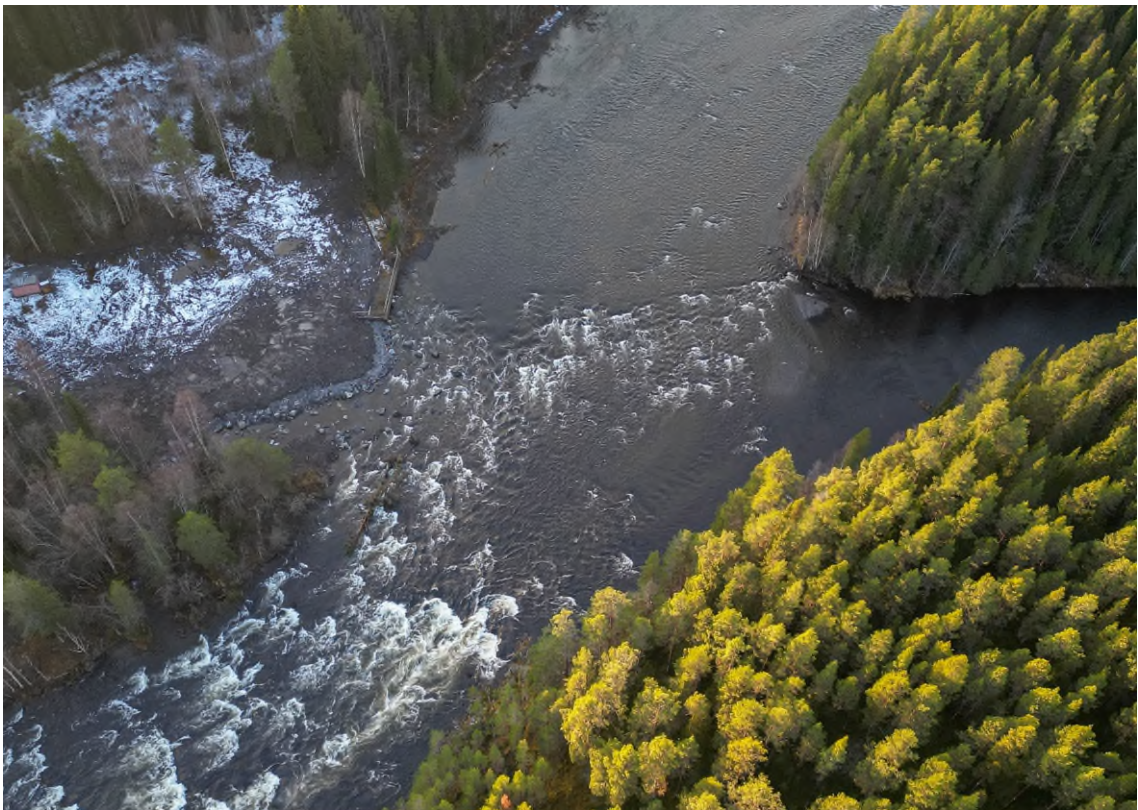
Figur 4. Flygfotot visar läget för överfallsdammen efter rivningen.
