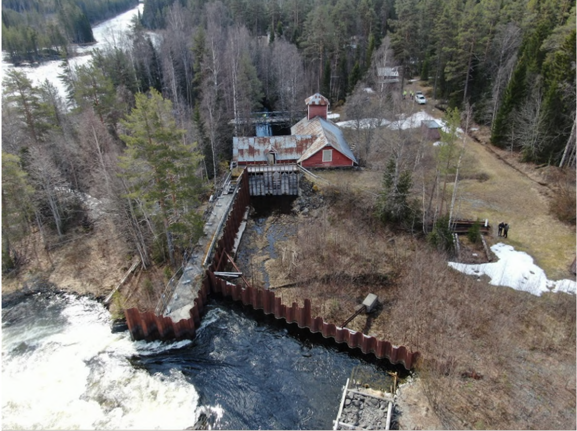
Figur 9. Flygbilden visar den torrlagda intagskanalen och kraftstationen hösten 2023.
