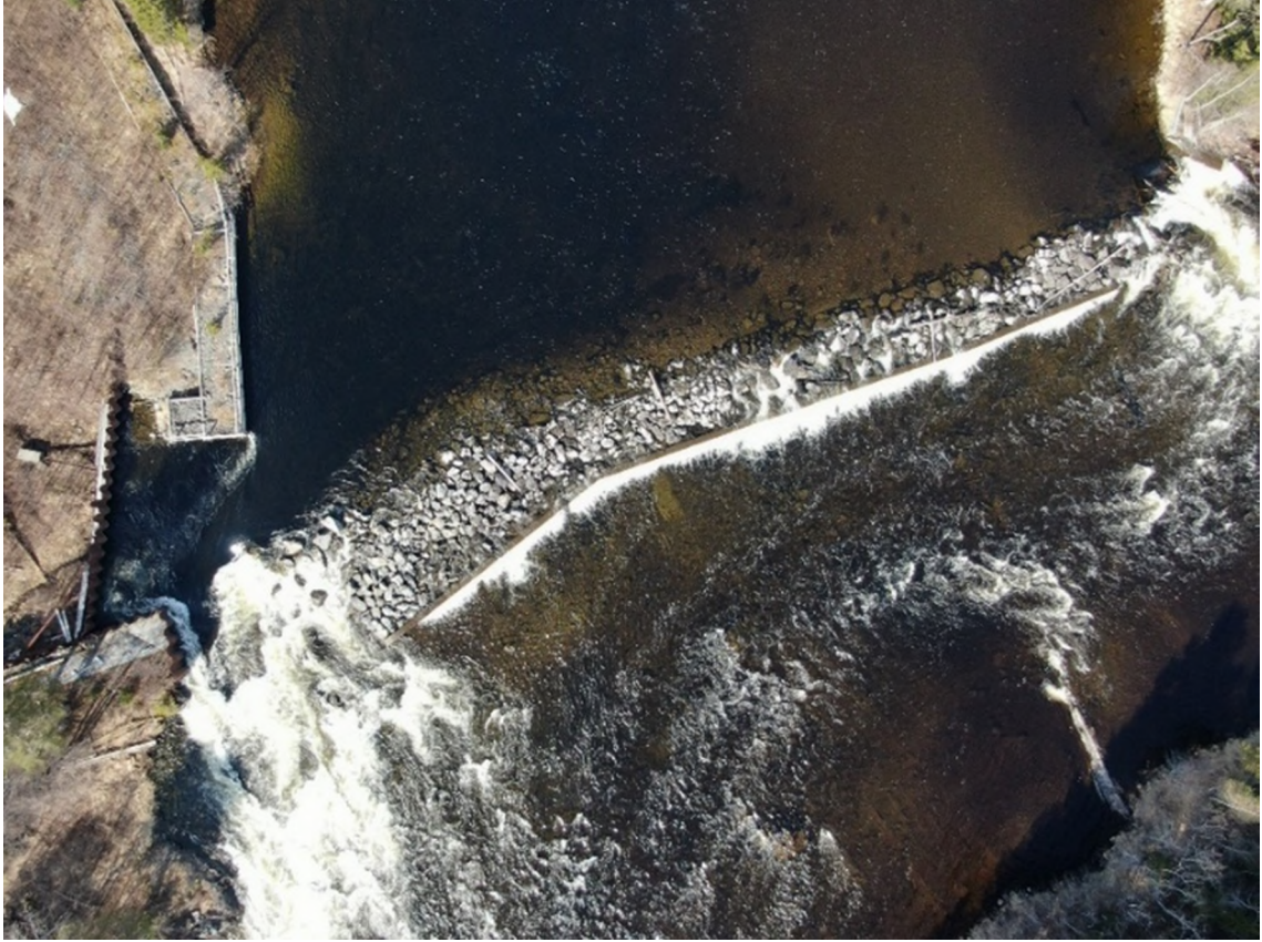
Figur 5. Flygfotot visar överfallsdammen före rivningsarbetena. Kraftstationen strax utanför bild till vänster.
