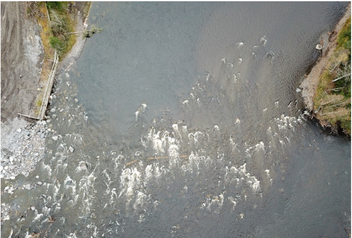
Figur 6. Flygfotot visar läget för överfallsdammen efter rivningen.
