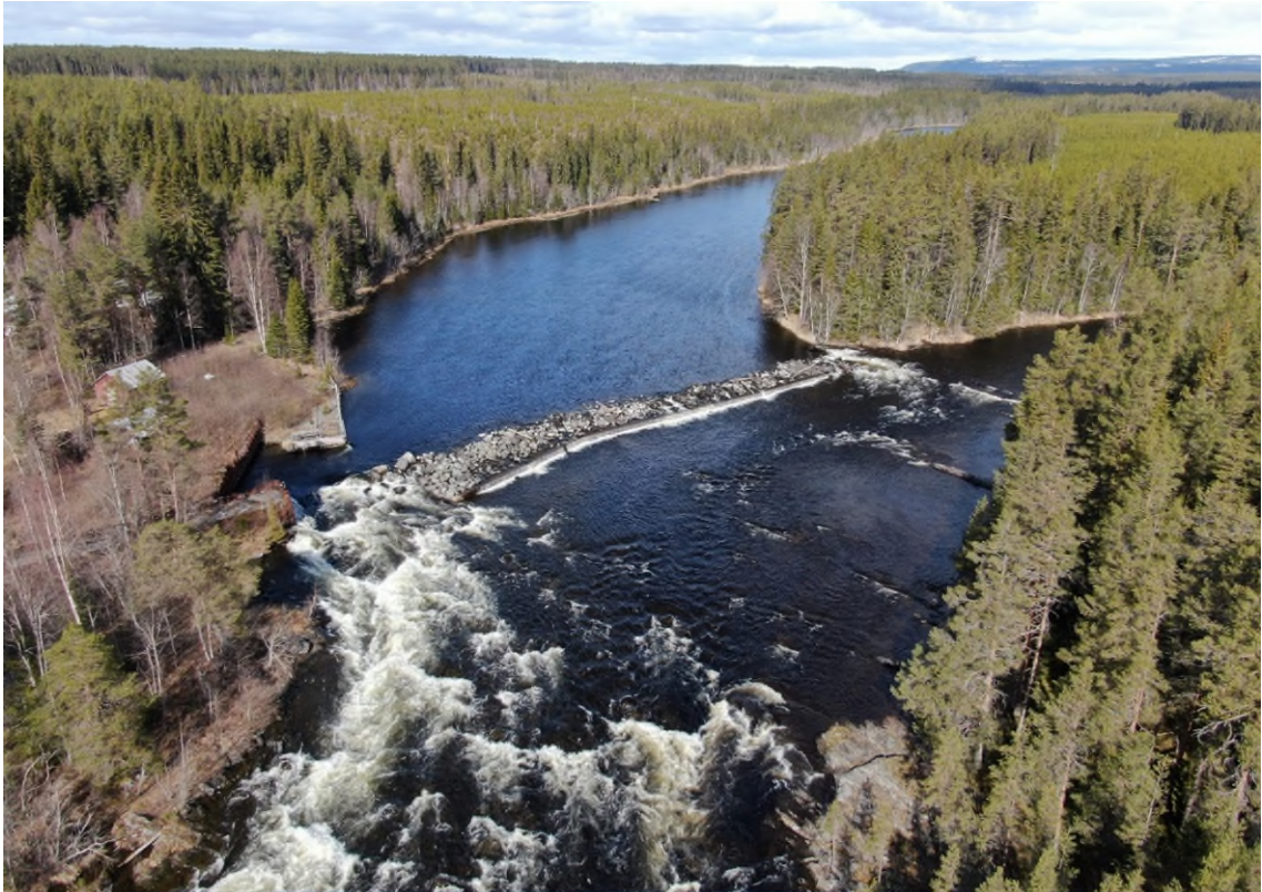
Figur 3. Flygfotot visar överfallsdammen före rivningsarbetena. Kraftstationen strax utanför bild till vänster.
