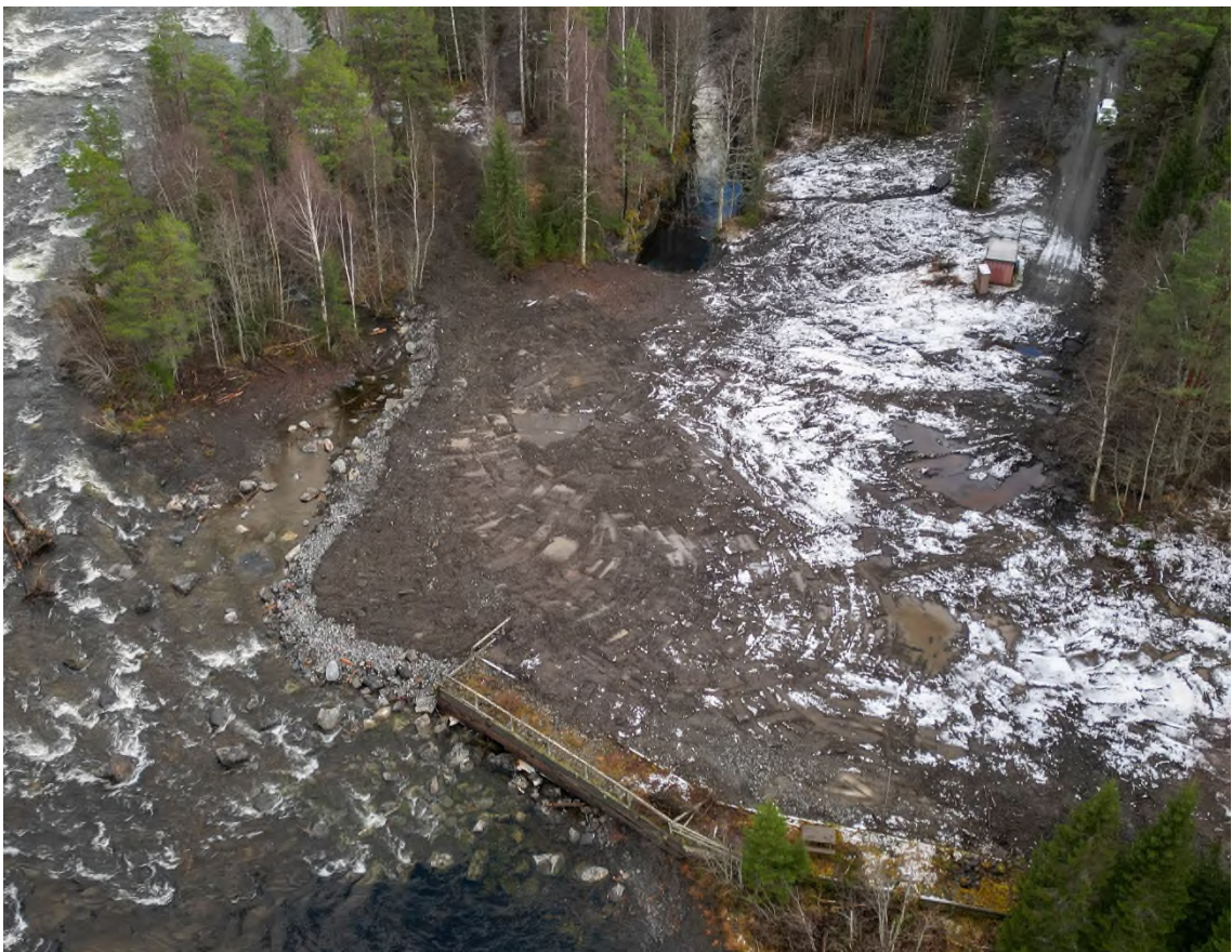
Figur 10. Flygbilden visar läget för kraftstationen efter rivningsarbetena 2024. Till vänster i bilden syns den sidofåra som skapades mellan forsen och det tidigare isutskovet.
