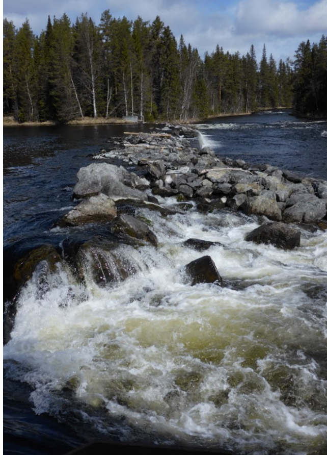
Figur 7. Fotot visar överfallsdammen från höger sida.
