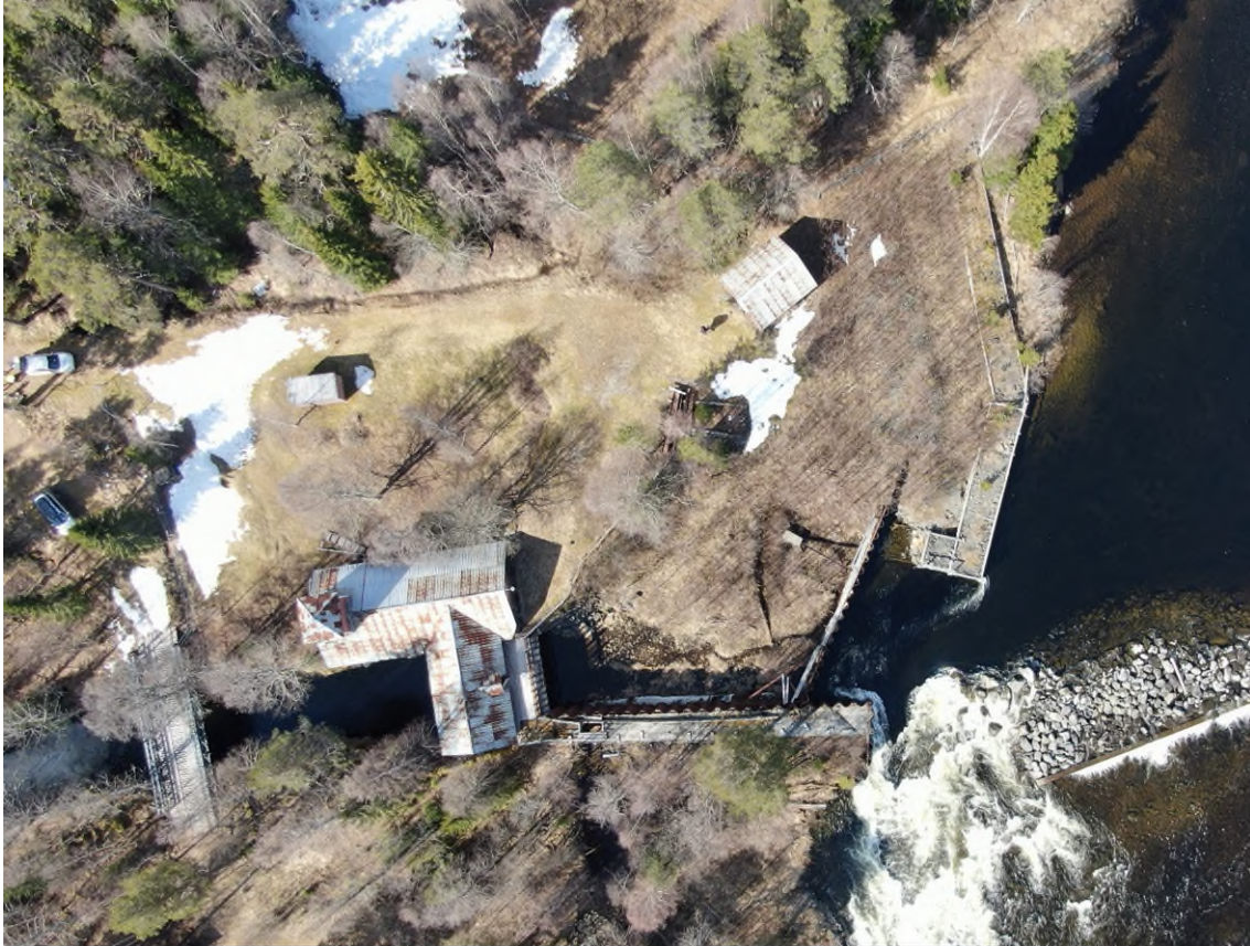
Figur 1. Flygfotot visar kraftstationen 2023.
