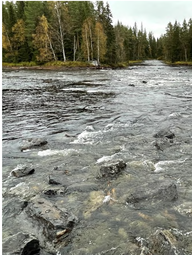
Figur 8. Fotot visar läget för överfallsdammen efter rivning.
