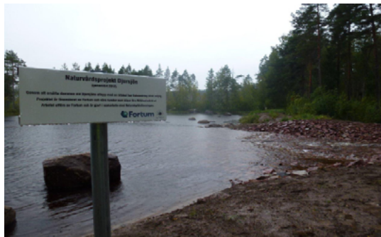
Djursjöns utlopp efter åtgärden
