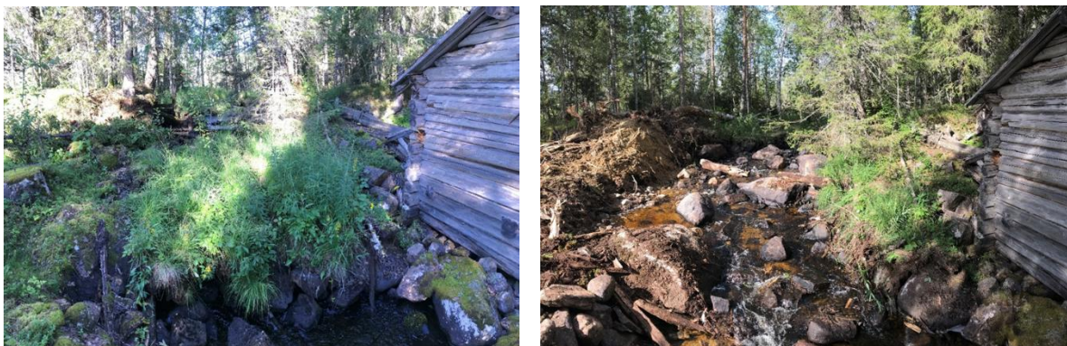
Figur 20: Skibord nedströms Ilvänderträsket. T.v. innan åtgärd och t.h. efter åtgärd.
