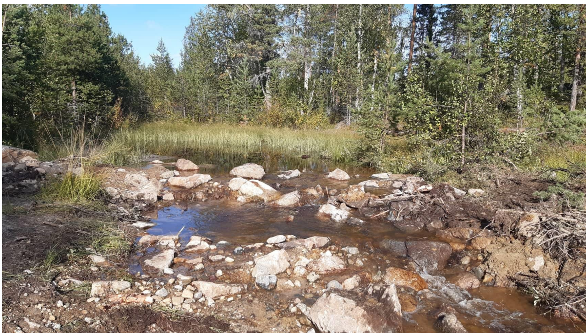
Figur 16: Ny forsacke som höjer nivån uppström med cirka 50 cm jämfört med innan åtgärd. Foto taget efter justering.
