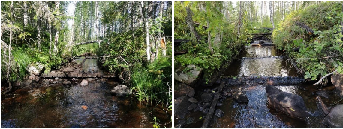
Figur 8: Ruttentjärndammen före åtgärd t.v. och efter åtgärd t.h.
