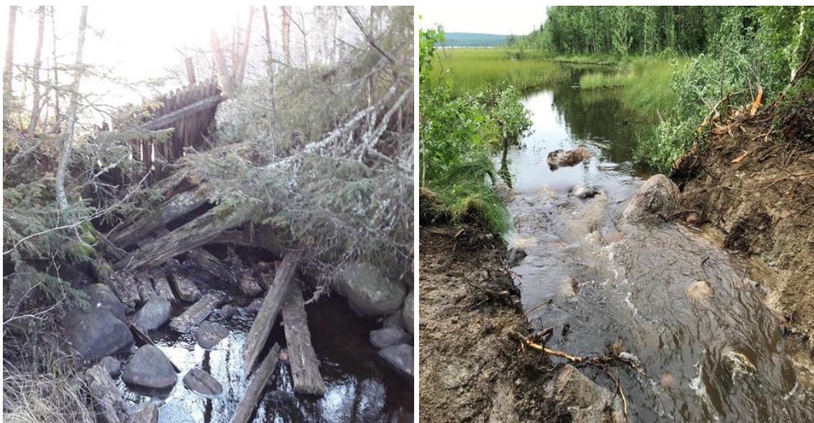
Figur 27: Järvträskdammen Tallån innan åtgärd t.v. samt efter åtgärd t.h.
