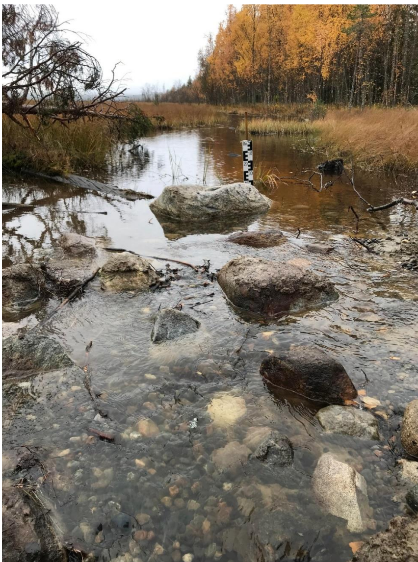
Figur 28: Resultatet efter justering då nytt material tillfördes för att förstärka den nivåställande tröskeln.
