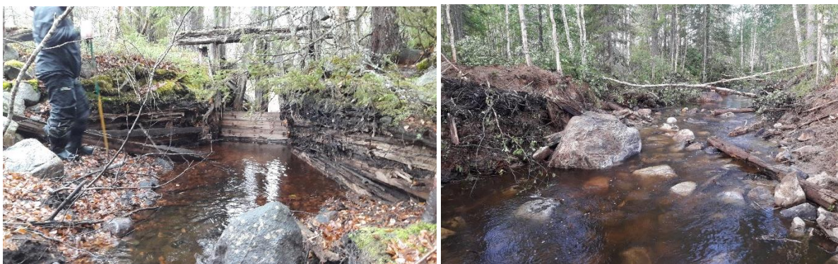
Figur 15: Lilla Holmtjärnsdammen före åtgärd t.v. och efter åtgärd t.h.
