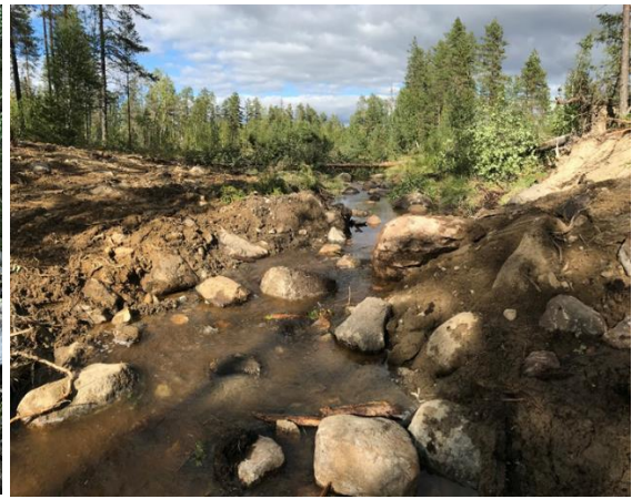
Figur 17: Ny längre strömsträcka på platsen där dammen låg. T.v. före åtgärd och t.h. efter åtgärd.
