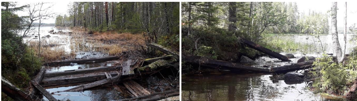
Figur 7: Gäddträskdammen före åtgärd t.v. och efter åtgärd t.h..
