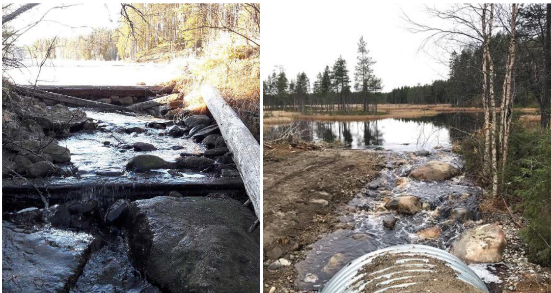
Figur 30: Vy uppströms vägtrumman mot sjön före åtgärd t.v. samt efter åtgärd t.h.
