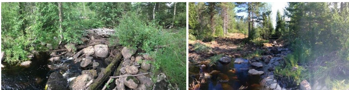
Figur 22: Kroksjödammen innan åtgärd t.v. samt efter åtgärd t.h..
