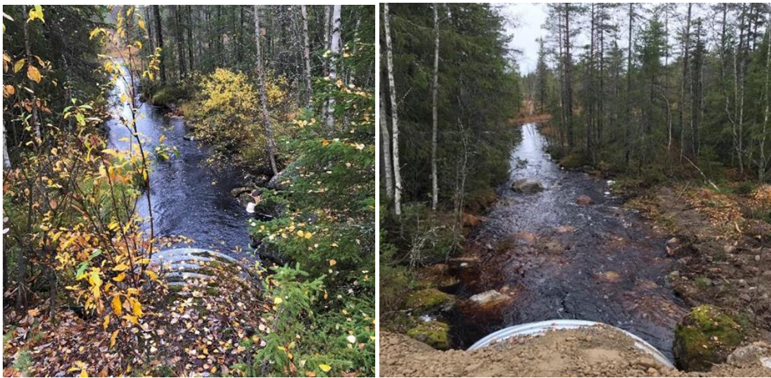
Figur 29: Vy nedströms vägtrumman före åtgärd t.v. samt efter åtgärd t.h.
