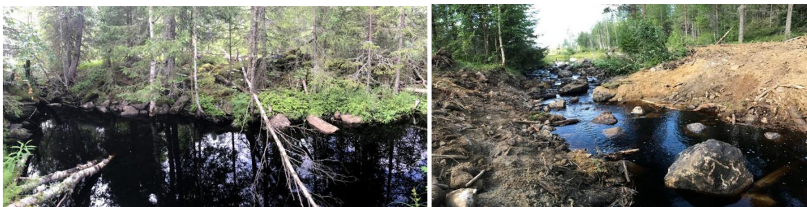
Figur 23: Den nya forsacken samt strömfåra som anlades Kroksjödammen.
