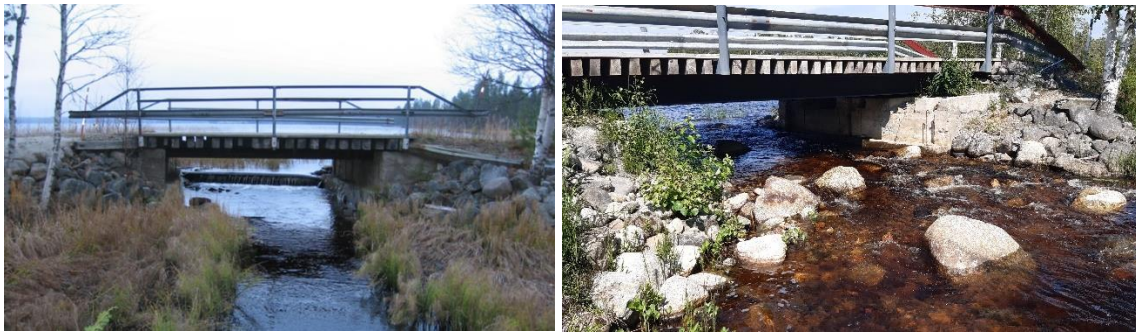
Figur 19: T.v. ses betongtröskeln som vid låga flöden utgör ett vandringshinder för fisk. T.h. har en ny bäckbotten byggts upp och balken klätts in med tillfört stenmaterial.
