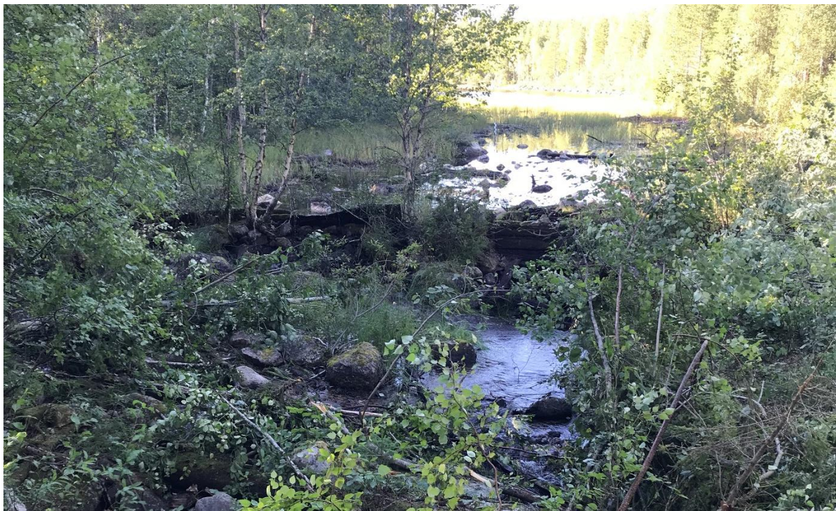
Figur 11: Järvträskdammen Sikån före åtgärd.
