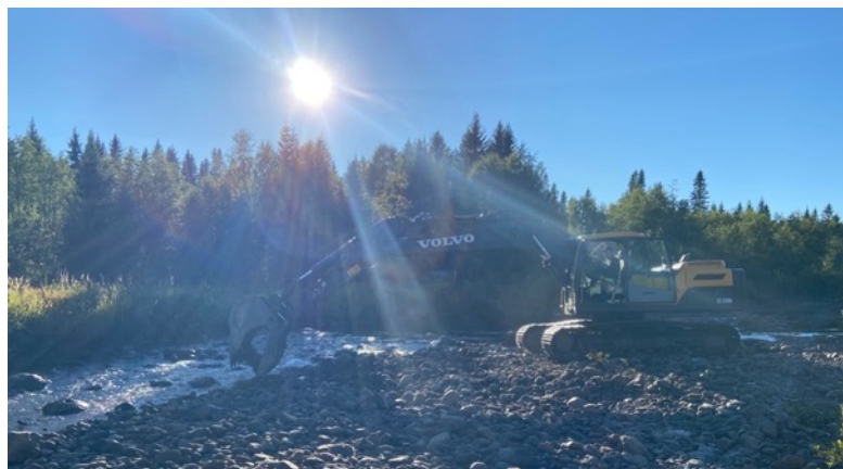
Arbete med att tillföra block och fördjupa höljor i området.
