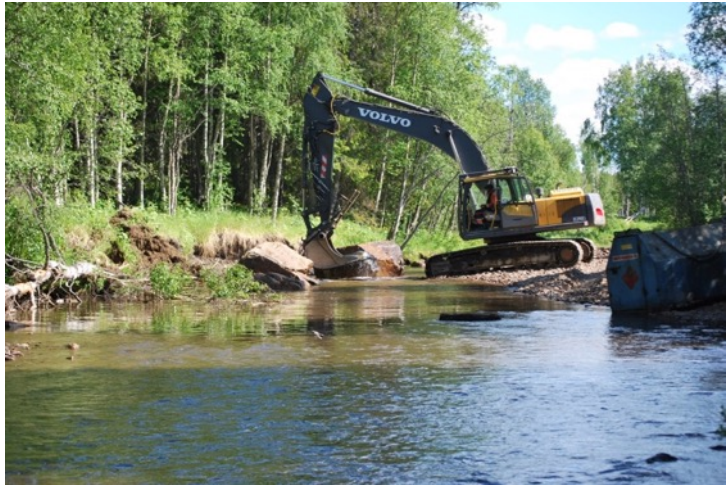
Utläggning av stora block (tidigare restaurering).
