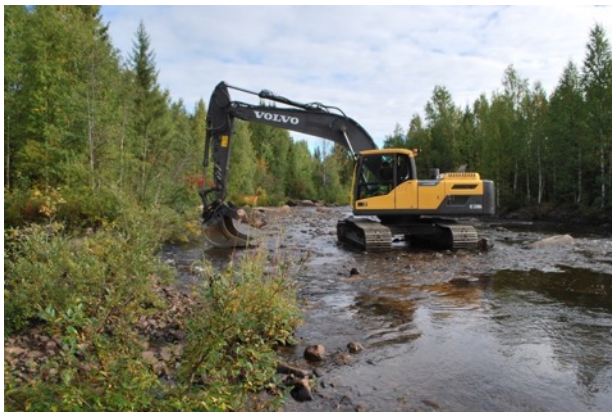
Grävmaskin i arbete på sträckan.
