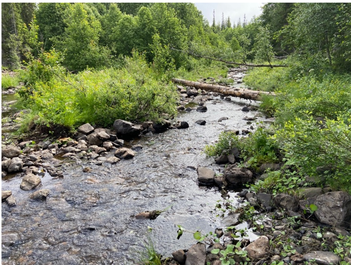
Efter att vi öppnat upp fåran strömmar nu vattnet återigen i fåran.
