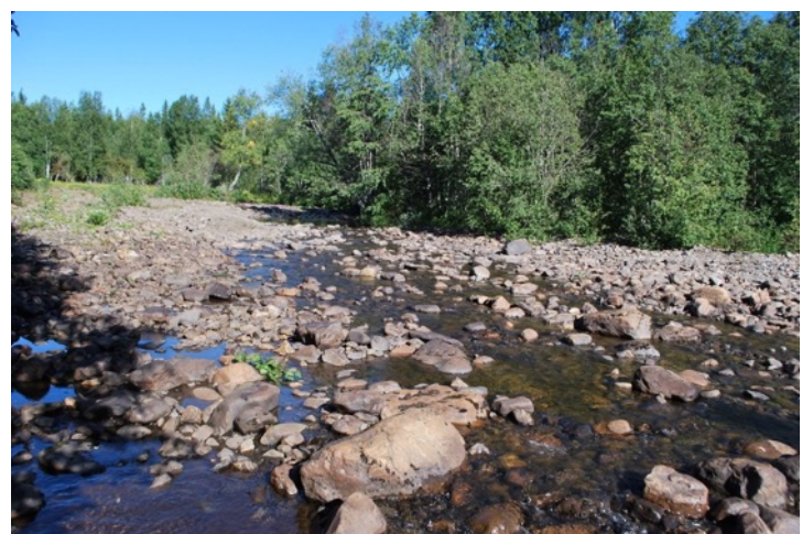
Efter åtgärden strömmar vatten i fåran igen.
