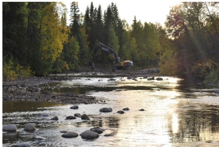
Efter åtgärd (tidigare restaurering).
