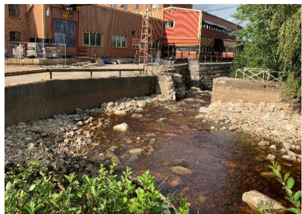
Damm och färdig fiskväg från uppströms sida efter åtgärd.
