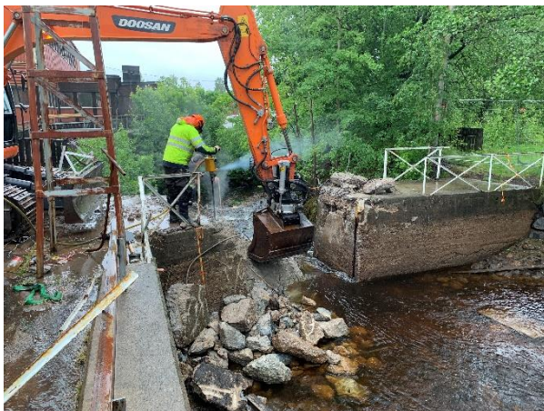
Dammen revs till en början ut genom borrhning och sprängning med lågexplosiva medel.
