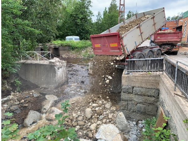
Dumpning av naturmaterial direkt nedströms dammen.
