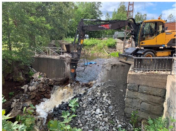
Under vattenytan genomfördes fortsatt utrivning med hjälp av en hydraulisk hammare kopplad till en grävmaskin.
