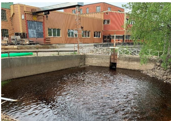
Damm från uppströms sida före åtgärd.
