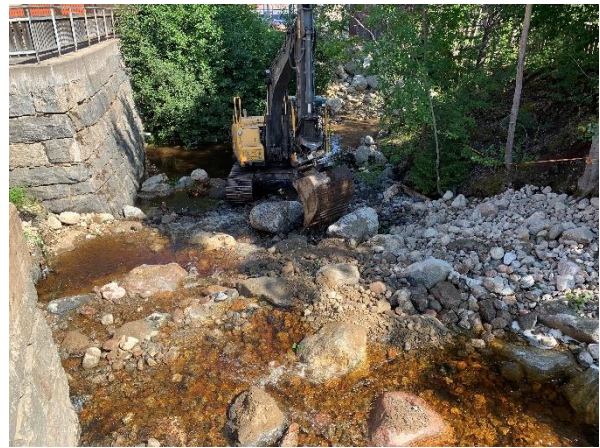
Bandgrävare under arbetet med att bygga upp en naturlig, låglutande fors på platsen.
