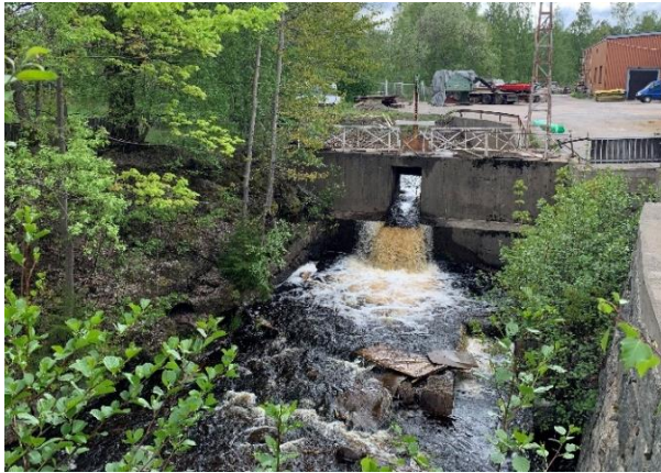
Damm före åtgärd.
