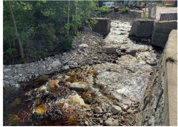
Öppnad damm och färdig fiskväg efter åtgärd.
