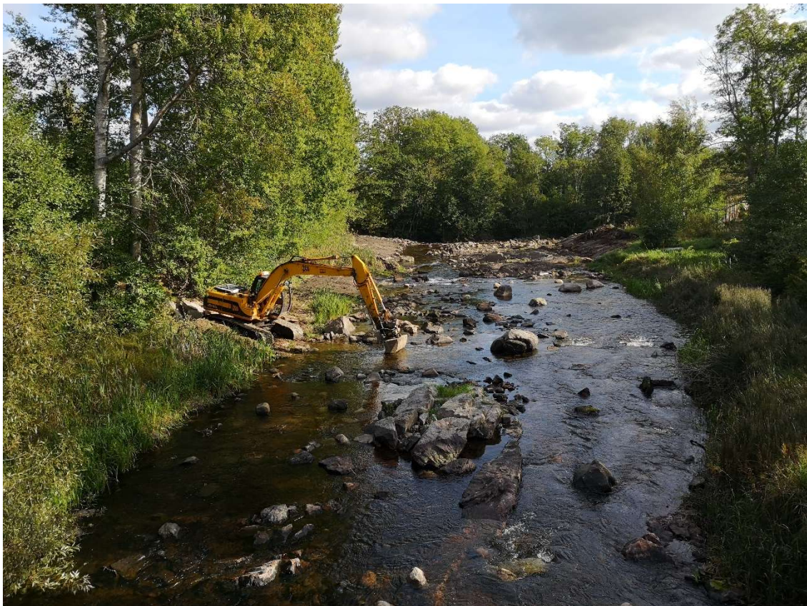
Dammområdet under pågående arbete.
