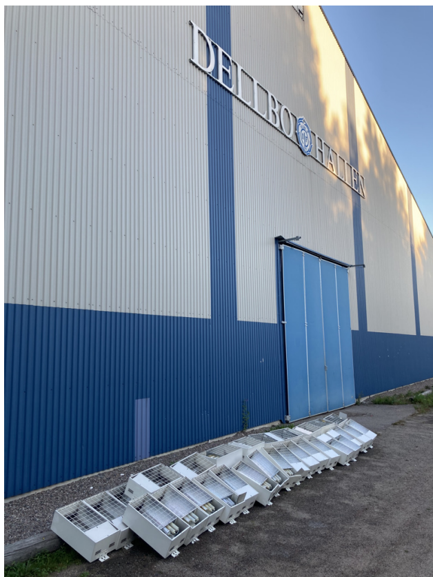
Bild 2. Nedmonterade äldre armaturer.
