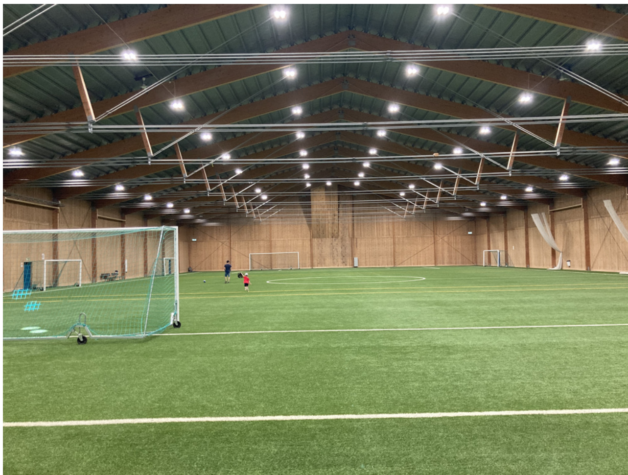
Bild 1. De nya LED-armaturerna har installerats.
