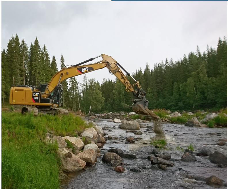
Forssträckan i sidofåran vid område 4 förses med grus. Här skapas möjligheter för öringlek och nedströms finns en god uppväxtmiljö för öringyngel.
