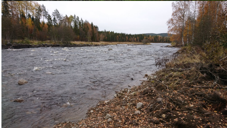
Område 3, på bilderna ovan syns uppströms vy före och efter och på bilderna nedan syns nedströms vy före och efter. En bred grässvål har lyfts bort och sten har flyttats ut för att blottlägga gammal älvbotten.
