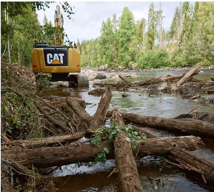
Död ved i vatten. När stenkistorna byggdes längs älvarna grundlades de ofta med timmerstockar. Dessa stockar har legat under vattnet och är därför i gott skick trots att de kan vara över 100 år gamla. Vid biotopvården är detta gamla virke en utmärkt källa till död ved att lägga ut i vattnet. Stockarna på bilden har placerats ut i område 5, strax nedströms vindskyddet.
