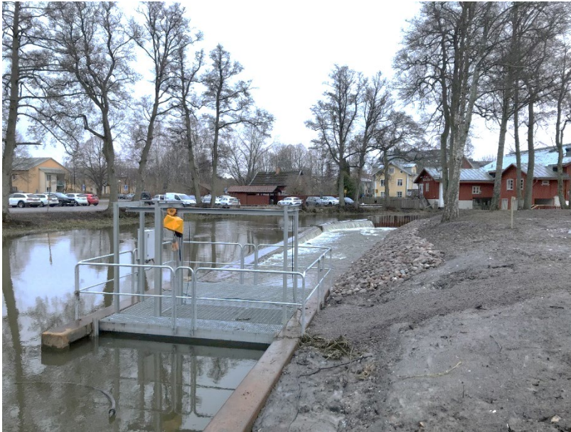
Trosa kvarn efter åtgärd. Inlöpets utsteg går genom fiskräknare med kamera. Foto: Trosa kommun.
