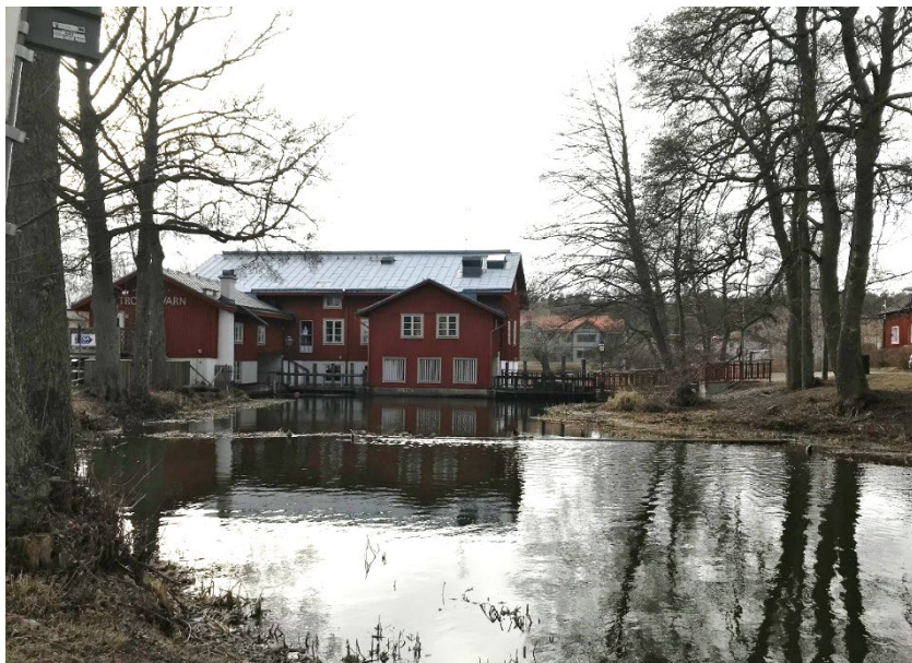
Trosa kvarn före åtgärd. Foto: Trosa kommun.
