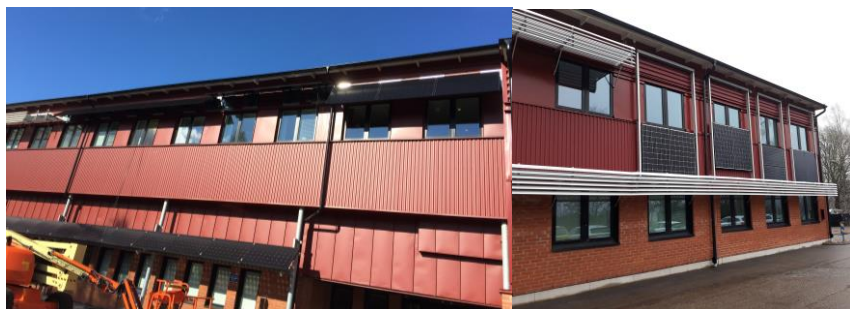
Demountinstallationen på RISE kontor i Borås visar dels den traditionella avskärmningen i aluminium utan solceller, en tidig fast solcellsinstallation i bottenplanet samt på övre planet i vänstra bilden en fast och en rörlig solcellsskärm från Solkompaniet. I den högra bilden visas fyra olika solcellsjalusier från PPAM.
