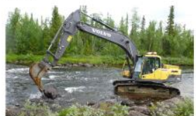
Bild 4. Vansamt och med skicklighet läggs block tillbaka i Marsån. Grävning utförs av fallströms AB. Foto: Magnus Lindberg, Länsstyrelsen Västerbotten.
