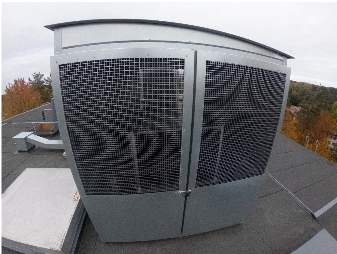
Filterlådan mellan överbyggnad över frånluftutblås och värmepumpen på taket Skeppargränd 3
