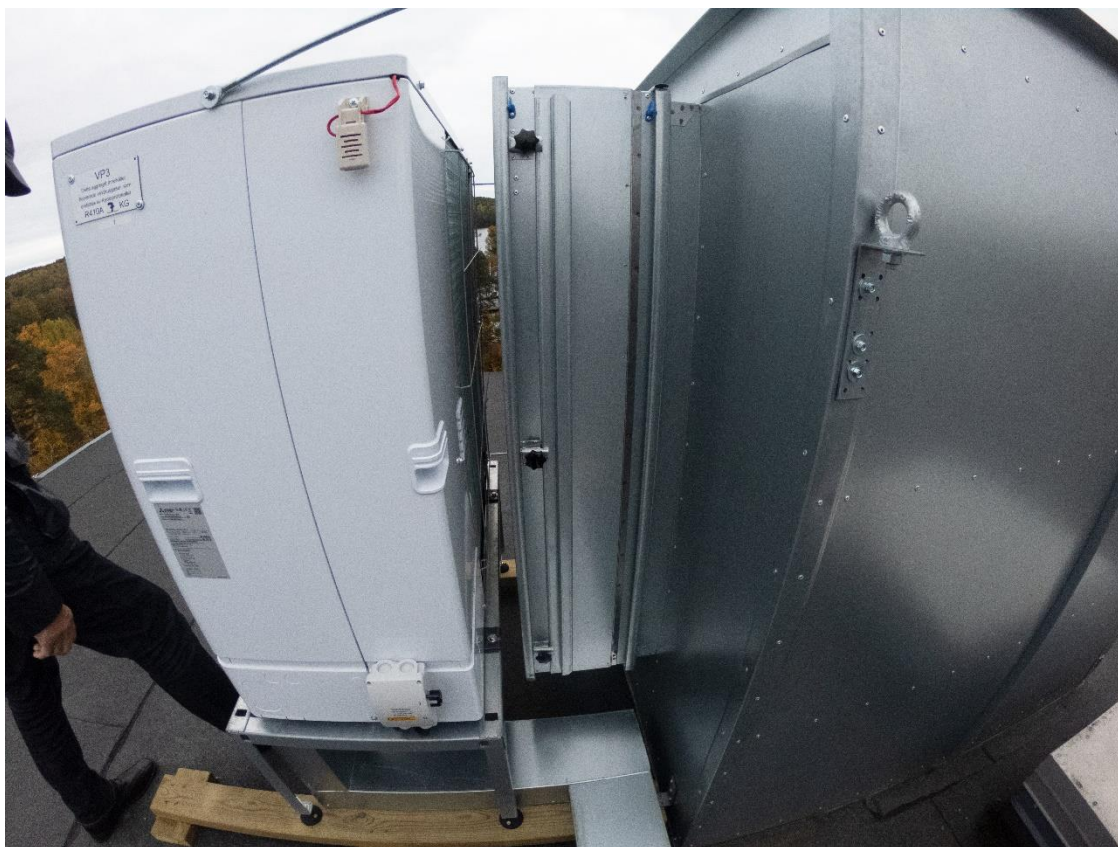
Filterlådan mellan överbyggnad över frånluftutblås och värmepumpen på taket Skeppargränd 3
