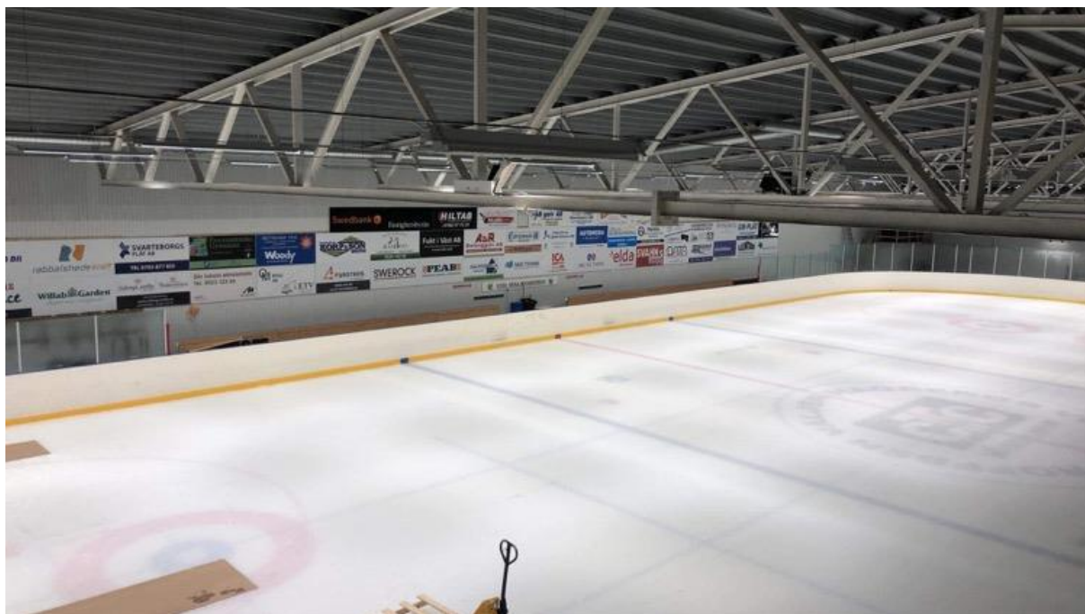
Bilden visar de gamla belysningsarmaturerna närmast i bild och montaget av de nya Led armaturerna längst bort efter en dags arbete.
