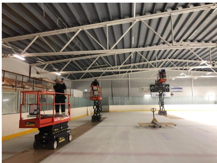
Dag 2 färdigställdes armaturmontaget, kvar var bara belysningsstyrningen efter detta.
