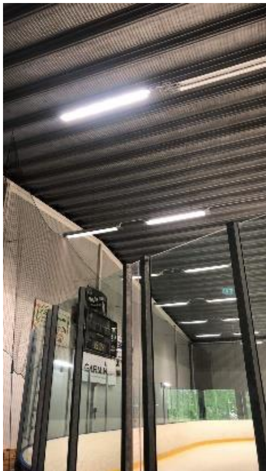
Bilden visar vårt första provmontage med en ny LED-armatur.
