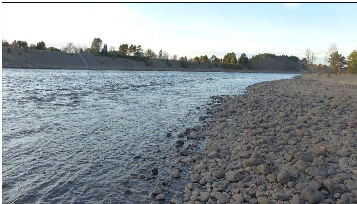
Fig. 11. Okarterad yta nedan Älvkarleby Kraftverk.
