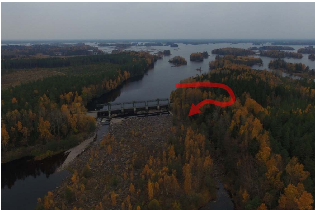
Figur 22. Ett omlöp anläggs vid Tensmyradammen för att säkerställa passagemöjlighet. Norconsult 2017.
