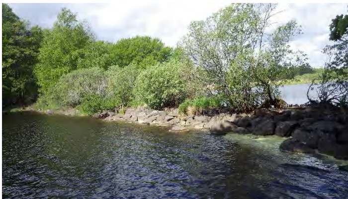
Fördämning 1, bestående av en 45 m lång och ca 0,5 m hög, stendamm som isolerar Spjutsundet från Hyttfjärden.
