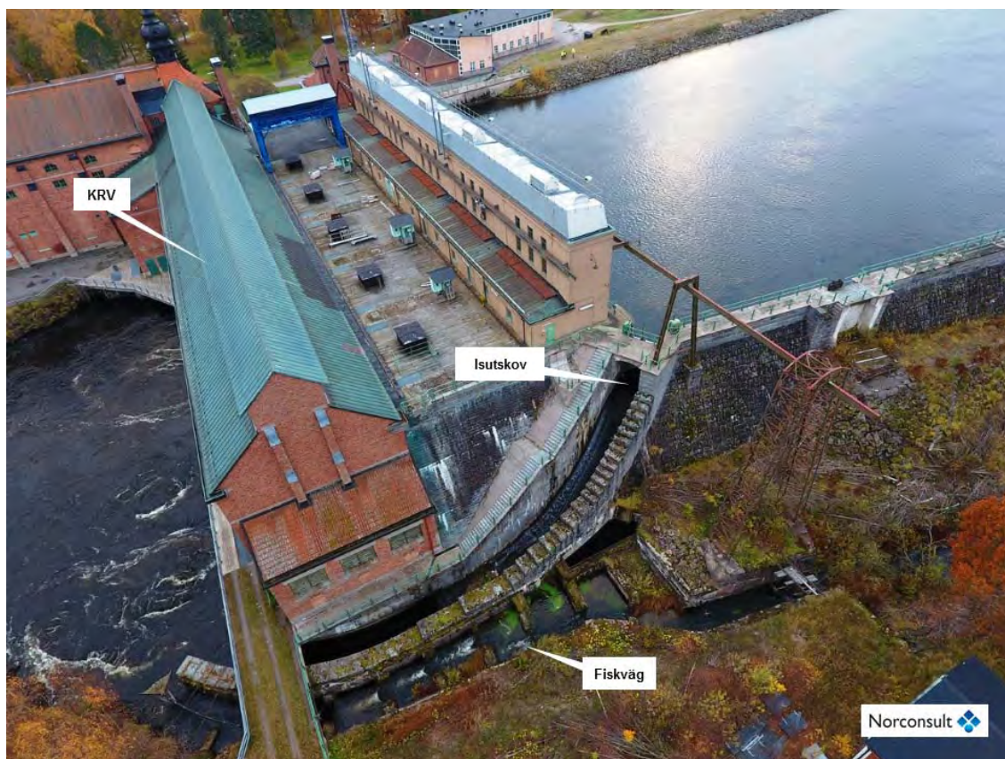
Figur 25. Untra kraftverk i Dalälven med befintligt isutskov och resterna av den gamla fiskvägen.
