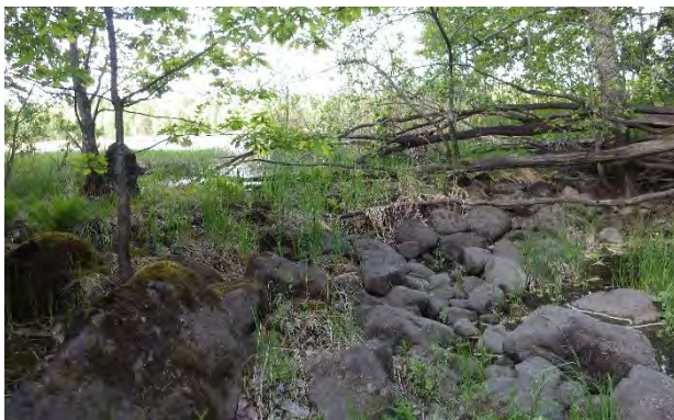
Fördämning 2 består av en ca 12 m lång stenvall som med en höjd av ca 1 m isolerar Hyttöfjärden från Båtforsströmmarna.
