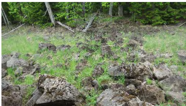
Fördämning 3, bestående av en 20 m lång blocktröskel som kommer att vara nivåhållande vid ett framtida högre flöde.
