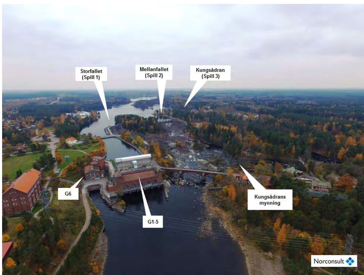
Figur 10. Översikt av Älvkarleby kraftverk med alternativa tappningsvägar och platser som berörs i texten. Foto från Norconsult AB.
