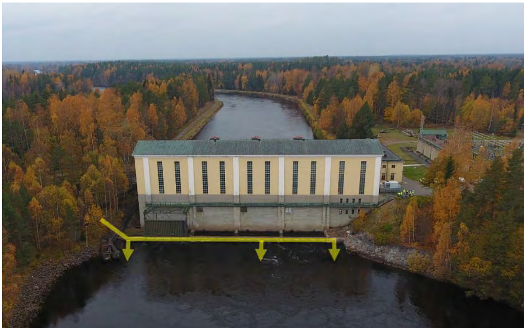
Figur 21. Utloppskanalen vid Lanforsen kraftstation är bred och medelvattenföringen hög. För att säkerställa en god anlockning för uppvandrande fisk bör flera utlopp (gula pilar) anläggas. Norconsult 2017.
