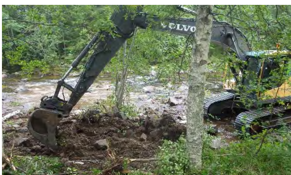
Exempel på strandzonsöppning/flödesanpassning av ett vattenkraftpåverkat vattendrag (Väljeån i Ljusdals kommun).
