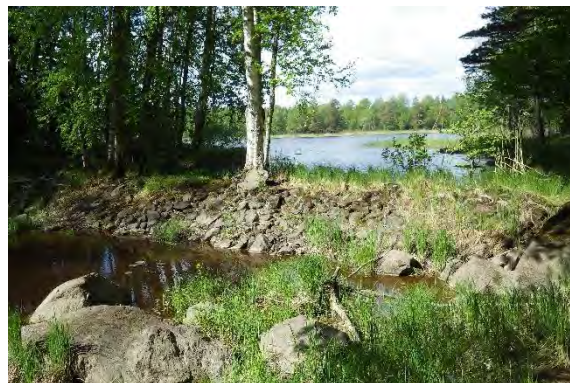
Fördämning 3 är en ca 15 m lång och 1-1,5 m hög stenvall som har samma funktion som föregående.
