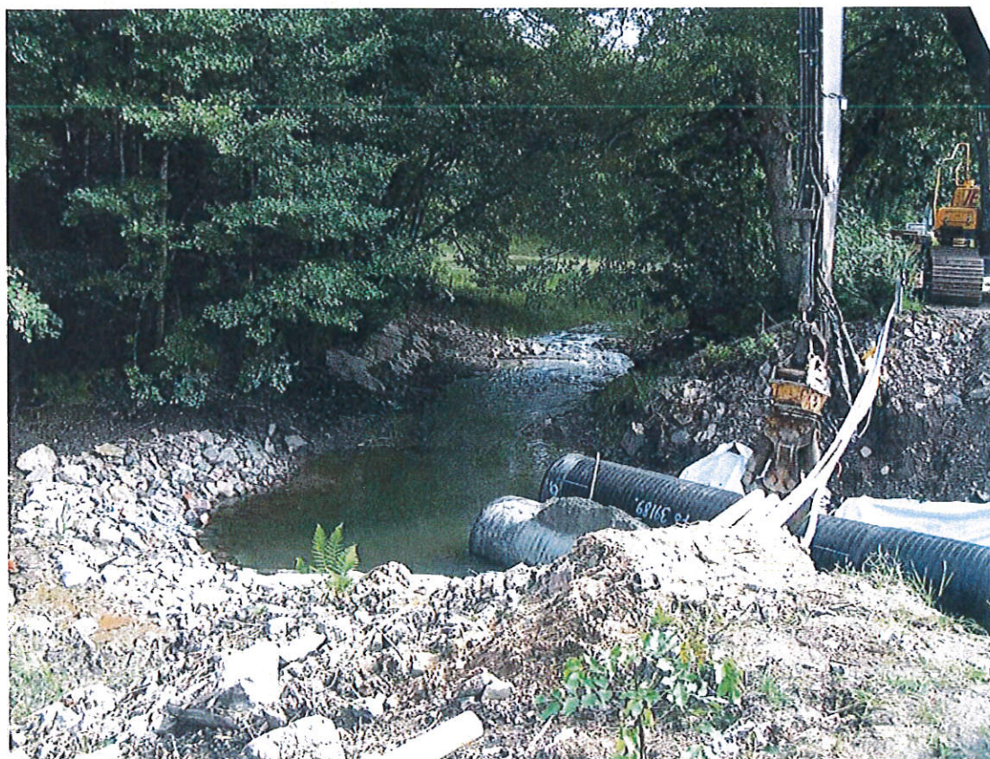
Byte av vägtrummor, Önafors
