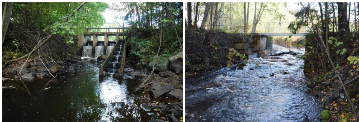
Figur 1. Östra dammutskovet före respektive efter åtgärd.
