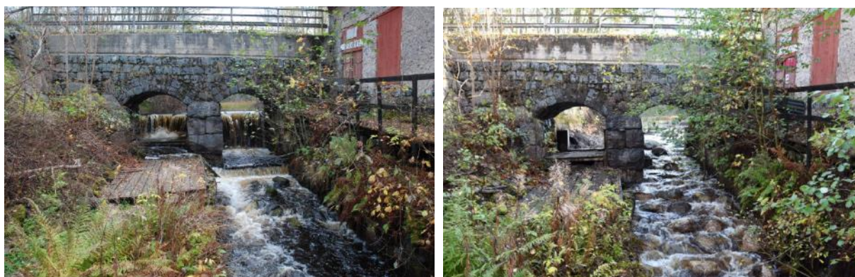
Figur 2. Västra dammutskovet före respektive efter åtgärd.
