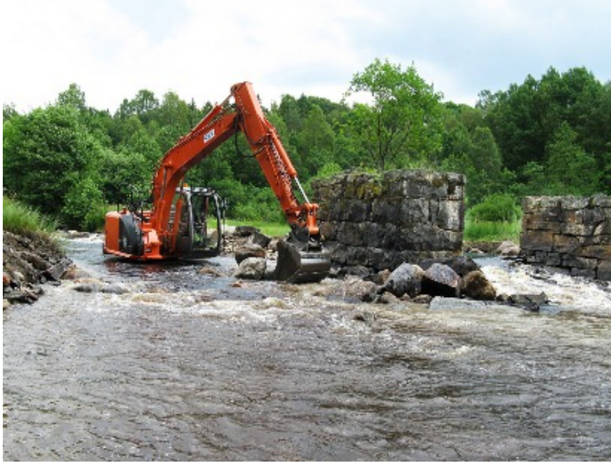
Juni 2012: Arbete med fiskväg vid Hulta damm. Foto: Robert Versa.
