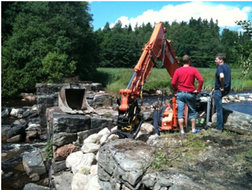
Arbete pågår vid Hulta damm i juni 2012. Foto: Susanna Hogdin.
