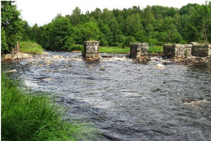
Juli 2012: Fiskvägen vid Hulta damm är klar mellan pylonerna till vänster. Foto: Robert Versa.
