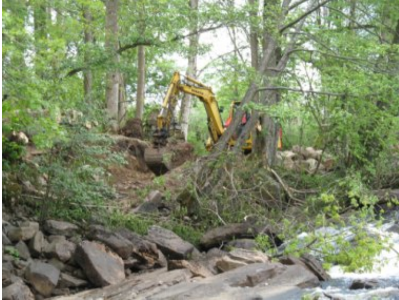
Grävmaskin i arbete med att anlägga omlöpet bredvid forsen vid Forsa kraftverk 19 maj 2008. Foto: Anna Ek
