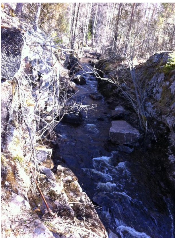
Foto 4. 2013-05-02 (efter åtgärd). Vy upp emot fiskvägens anslutning till dammen. Inga vandringshinder i vägen för öring och lax.
