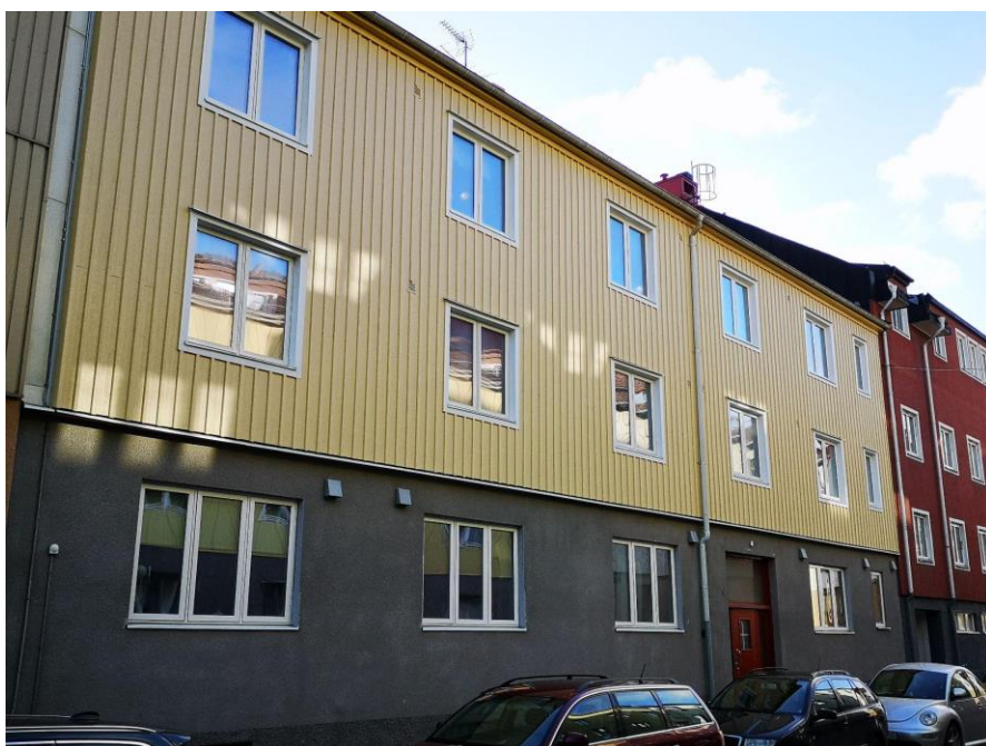
8. Fastighetens utseende idag efter renoveringen (mot Jägaregatan 4)
