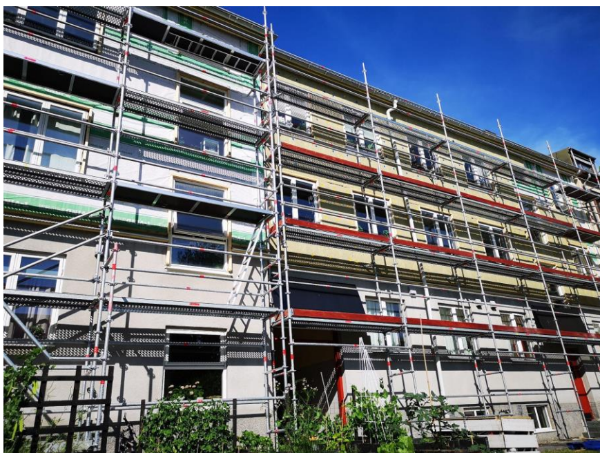
3. Ny tilläggsisolering på fastigheten som vetter mot innergården
