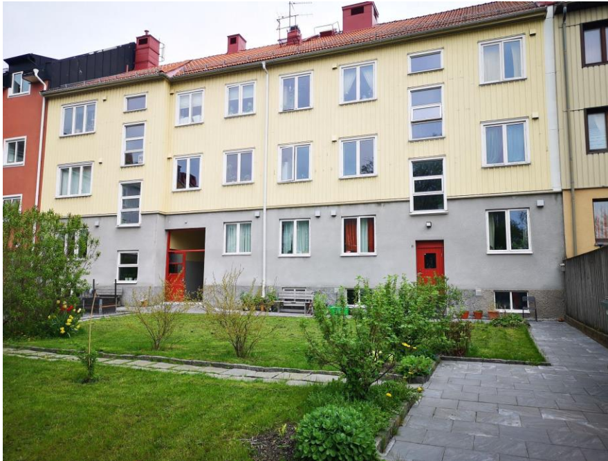
1. Fastigheten innan fasadrenovering (mot innergården)
