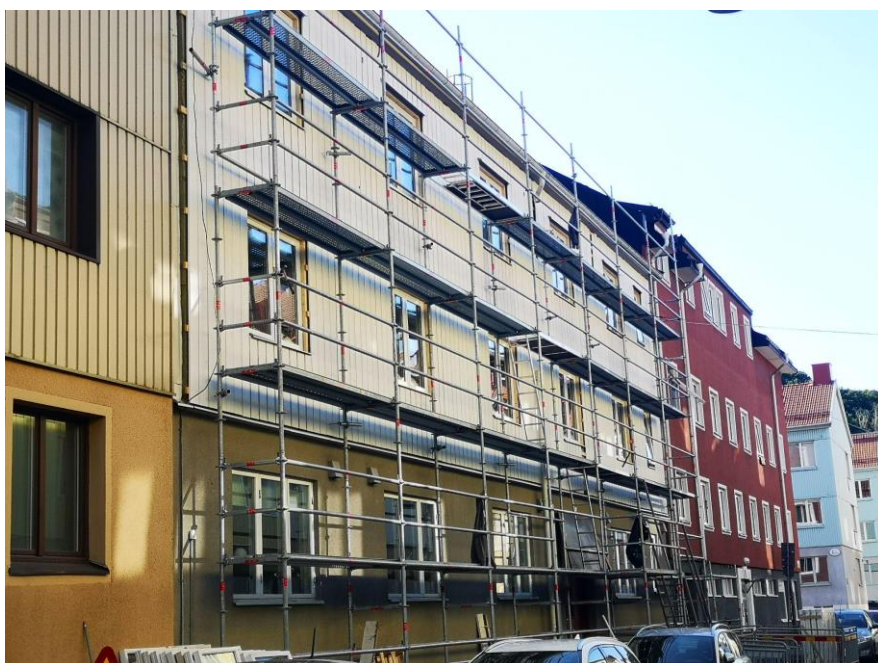
6. Ny fasad på fastigheten som vetter mot Jägaregatan
