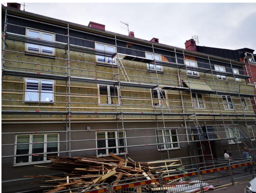
5. Ny tilläggsisolering på fastigheten som vetter mot Jägaregatan
