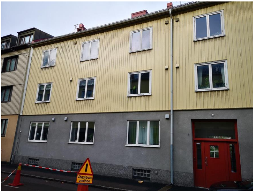
2. Fastigheten innan fasadrenovering (mot Jägaregatan 4)
