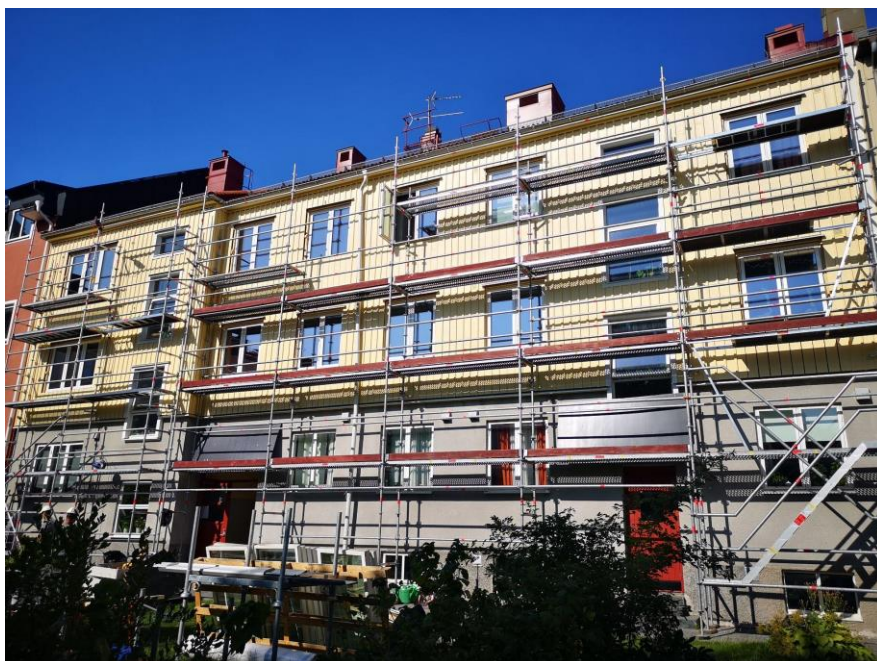
4. Ny fasad på fastigheten som vetter mot innergården
