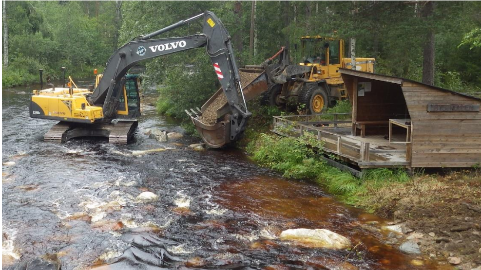
Exempel på anläggning av en strandnära lekbädd (Sträcka A, N6758388-E577201)
