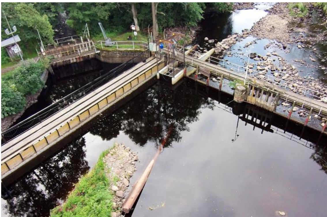
Bild 1. Testeboån vid Strömsbro kraftverk efter att fingaller, fiskvägar och fiskräknare installerats. Foto: Fiskevårdsteknik.
