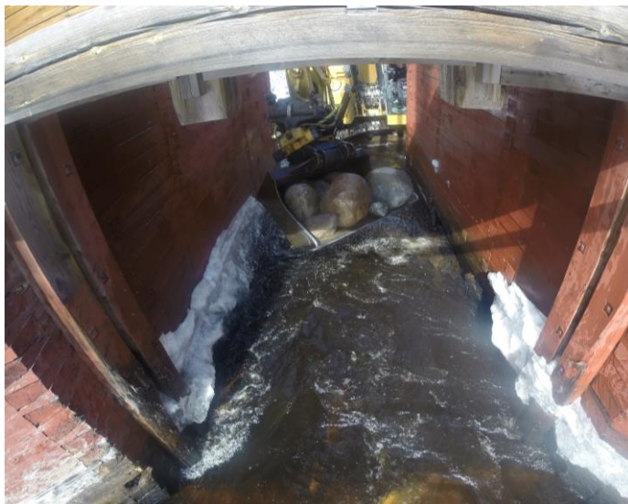
Figur 3 Block och stenar placeras ut för att minska vattenhastigheten och öka vattendjupet där slussgolvet tidigare låg. Foto: Henrik Viklands, Vattenfall.
