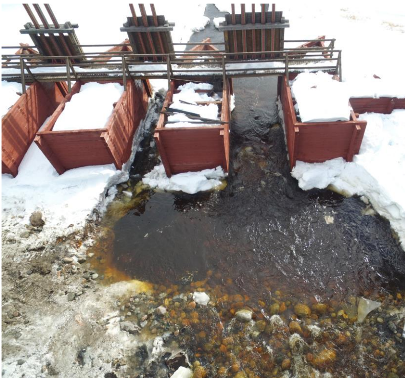
Figur 5 Block och stenar placerades ut för att minska vattenhastigheten och öka vattendjupet där slussgolvet tidigare låg. En tröskel med block anlades nedströms dammen för att öka vattendjupet i den rensade huvudfåran. Foto: Henrik Viklands, Vattenfall.
