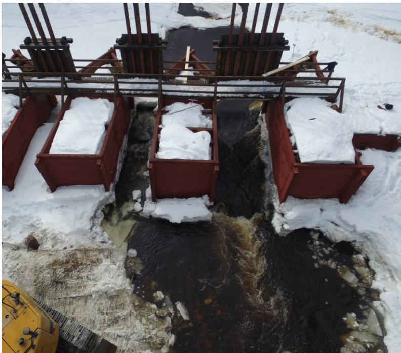
Figur 4 Våren 2018, innan åtgärd av slussgolv. Slussgolvet längst till höger i bild var det som åtgärdades. Vattenhastigheten över slussgolvet var innan åtgärd mycket hög. Åtgärden genomfördes innan vårfloden hade kommit igång. Foto: Henrik Viklands, Vattenfall.
