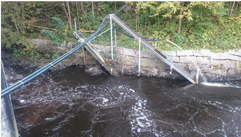
Bild 2. Ålyngeluppsamlare vid Pos. B och sammanlänkingsrör
