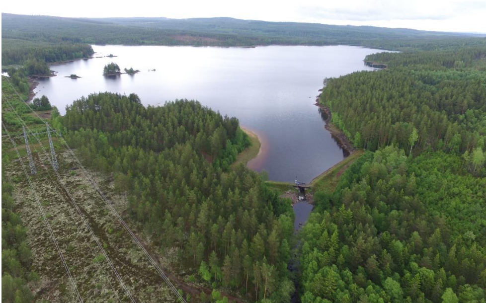
Foto 1 Acksjön före utrivning, foto Axel Emanuelsson, Norconsult
