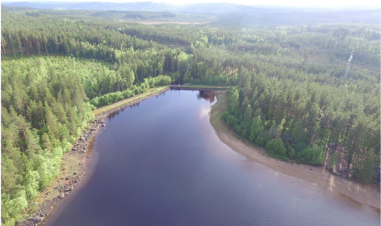
Foto 3 Utloppsviken före utrivning. Sjön är inte helt fylld. foto Axel Emanuelsson, Norconsult
