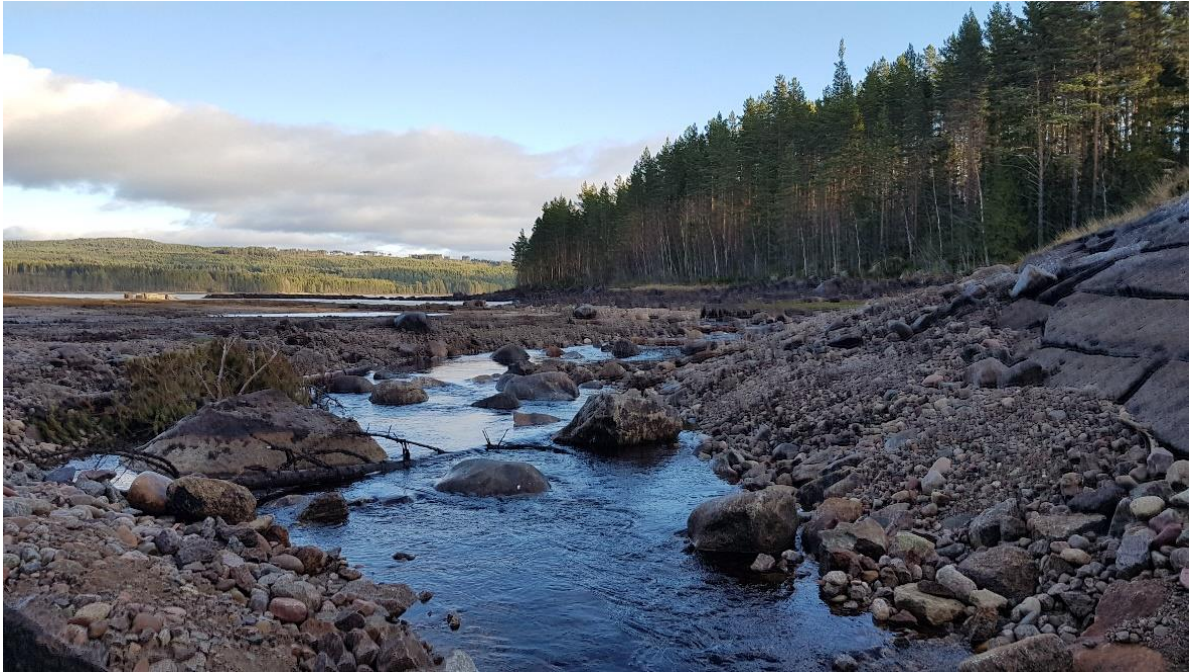
Foto 15 Utloppet på utskovets tidigare plats.
