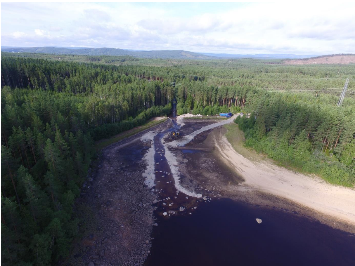
Foto 4 Utloppsviken under arbete, arbetsvägen och maskinen syns. Sjön ligger någon dm under den nivå som den kommer att ha. foto Axel Emanuelsson, Norconsult
