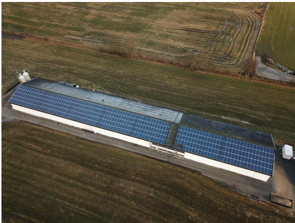
Bildet viser et av husene som har fått installert solceller
