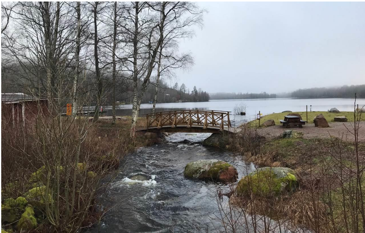
Bild 2. Utloppet efter åtgärd, sett nedströms ifrån. Ny gångbro ungefär på samma plats som de tidigare dammluckorna.
