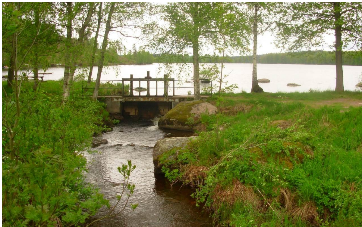
Bild 1. Utloppet innan åtgärd, sett nedströms ifrån.
