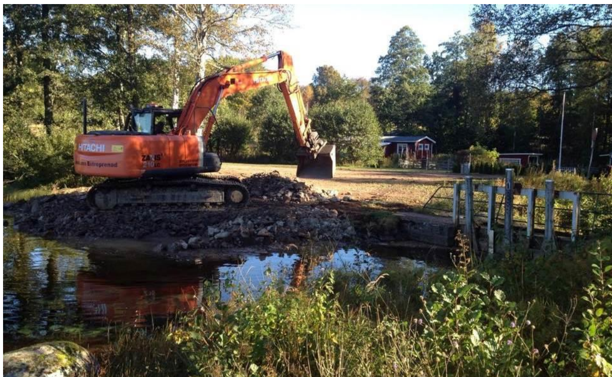
Bild 4. Det tidigare utloppet sett uppströms ifrån. Arbetet med uppbyggnad av det nya utloppet har precis inletts.
