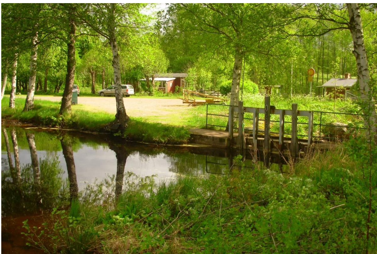
Bild 3. Det tidigare dämmet innan åtgärd, sett uppströms ifrån.
