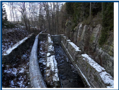
Vid Bäckefors kraftverk i Teåkersälven tas vattnet i en 500 meter lång tub från intagsdammen till turbinen. I ån finns länets största population av flodpärlmussla.
