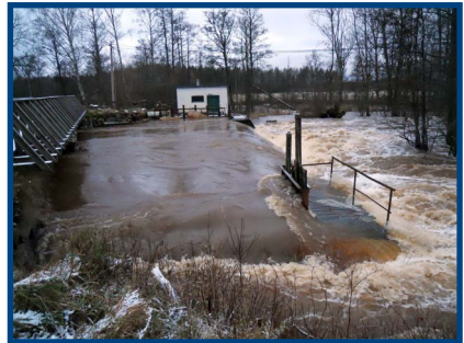
Armeneby kraftverk i Tidå. Vid många vattendrag observerades stora mängder spillvatten.
