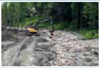
Med grävskopans hjälp har bäckfåran justerats i samband med provkörningar av vatten.
