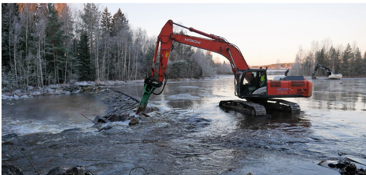
Figur 2. Bilning av betongtröskeln.
