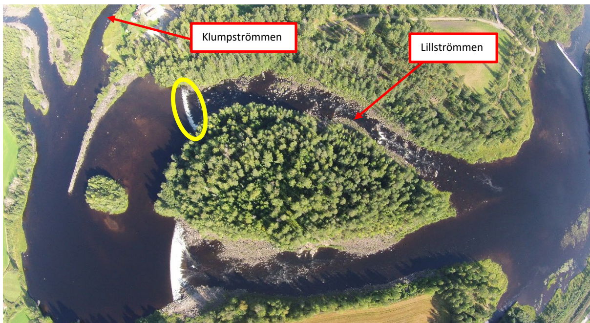
Figur 1. Översiktsvy arbetsområdet i etapp 1. Inringat den betongtröskel som skulle komma att avlägsnas.
