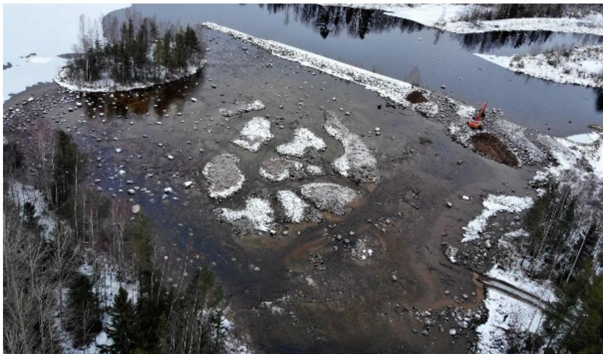
Figur 4. Översiktsvy över arbetsområdet från i samband med dess slutfas. All miljö är nu i princip av strömmande slag . Notera de skapade öarna och hur fåror just anläggs genom ledaren. Ytterligare fåror kommer att tillkomma efter fototillfället.
