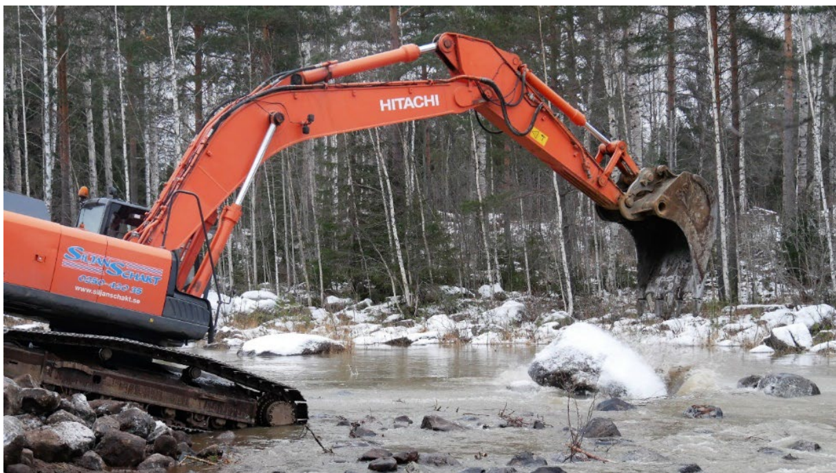
Figur 5. Block återförs i den rensade Lillströmmen i området nedströms den forna betongtröskeln.
