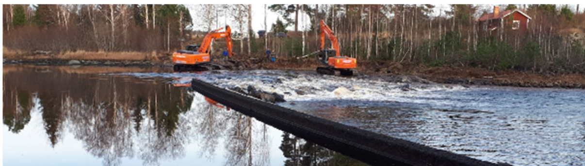
Figur 8. Foto från pågående bilning av den mäktiga betongtröskeln.
