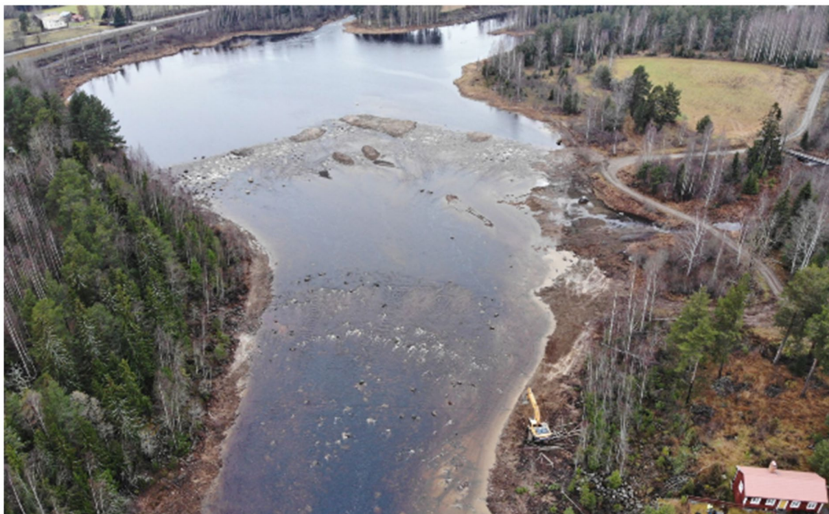
Figur 13. Vy ut över Brohöljan efter åtgärd.
