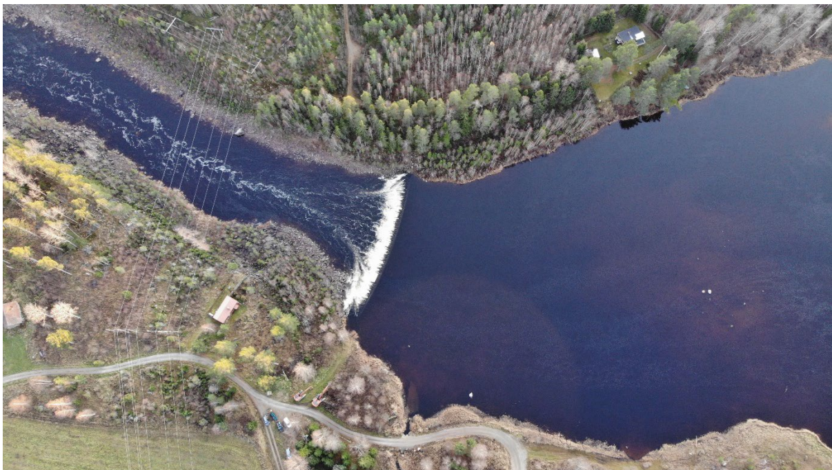
Figur 6. Vy över betongtröskeln, Brohöljan till höger i bild och Guldströmmen nedströms tröskeln.
