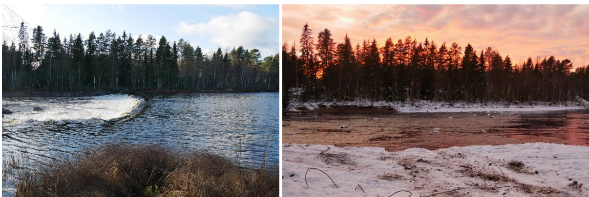
Figur 9 & 10. Före respektive efter avlägsnandet av betongtröskeln.
