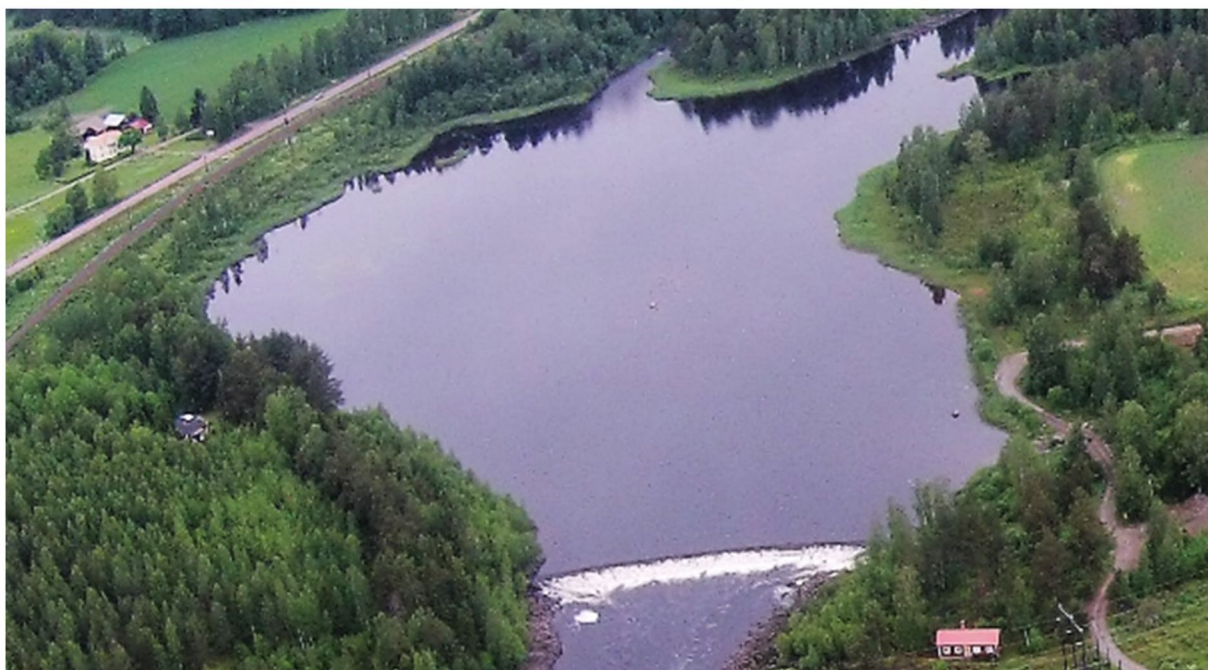
Figur 12. Vy ut över Brohöljan innan åtgärd.
