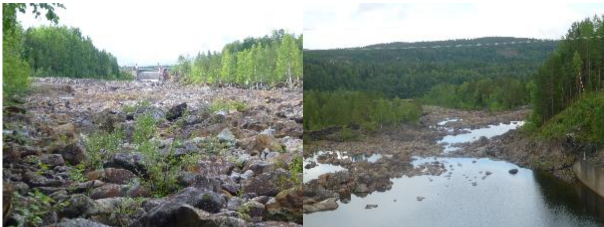
Figur 60. Torrfåra nedströms Harrsele kraftverk.
