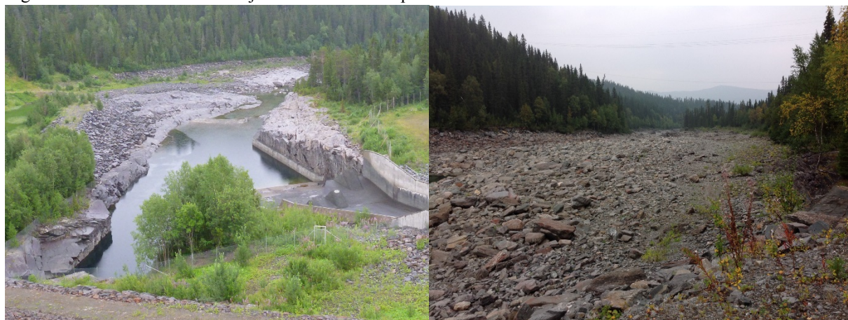
Figur 88. Vänster: Vy från Ajaure kraftverk utan spill. Höger: Fåran 300 meter nedströms.
