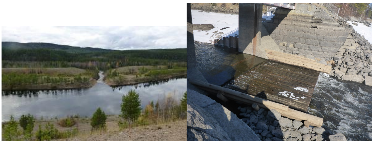
Figur 31. Vänster: Messjaur i Luleälven efter åtgärd. Höger: Flottningsdamm som utgör ett vandringshinder i Storumans dämningssområde vid låga vattenstånd.
