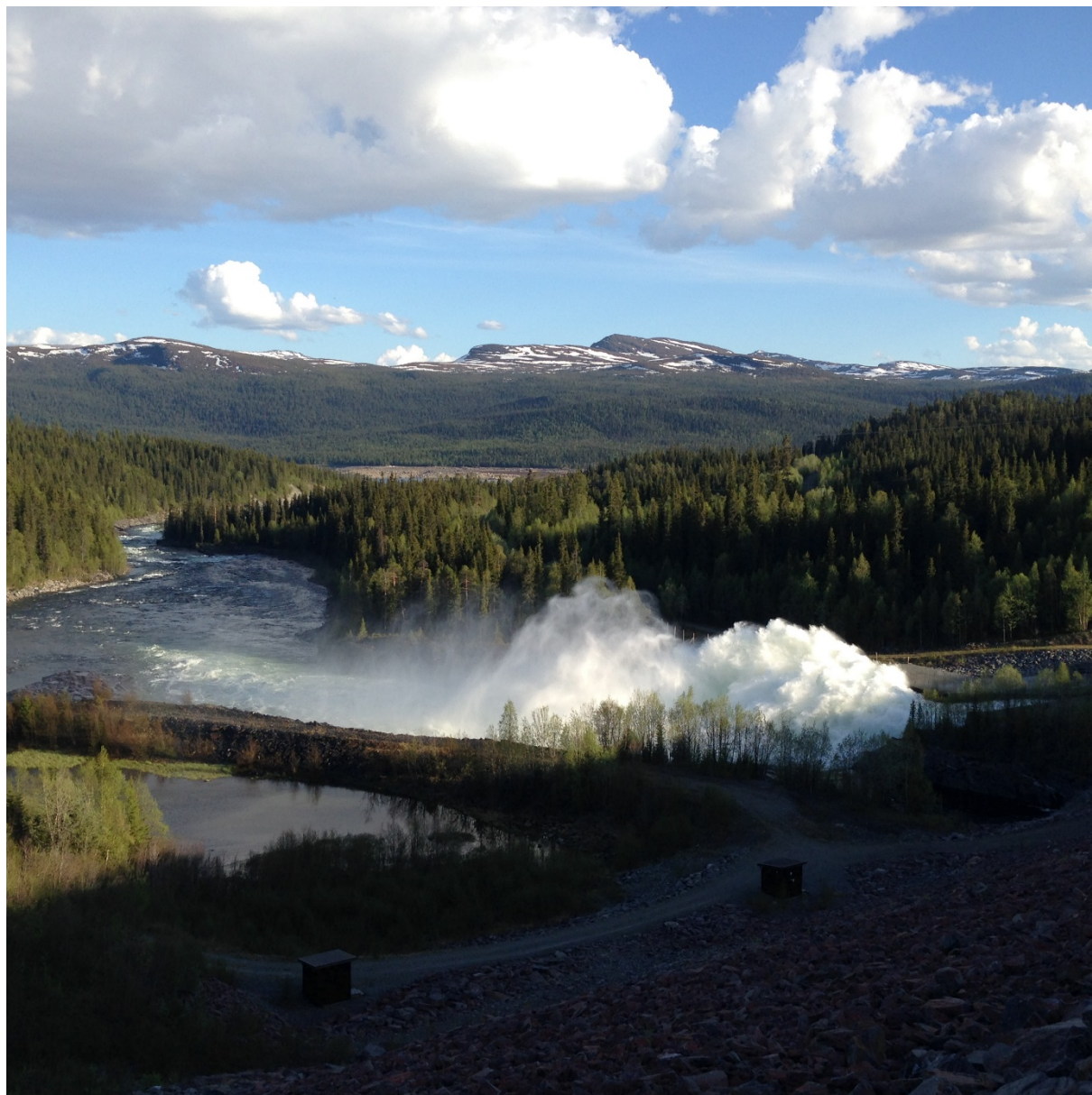
Figur 87. Torrfåran nedströms Ajaure kraftverk vid spill.
