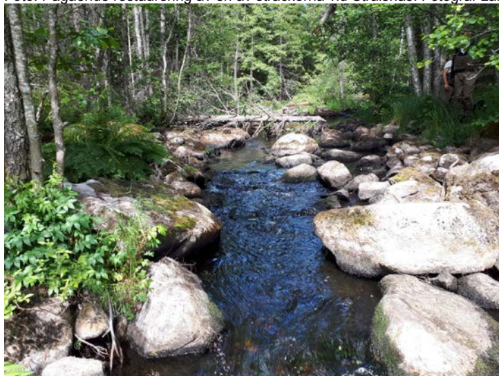
Foto: En av strömsträckorna vid Södra Timmerö, Boxholm, innan åtgärd. Fotograf Mattias Larsson.
