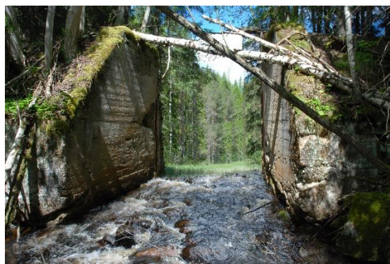
Bild nr 25: Utskovet efter åtgärd
