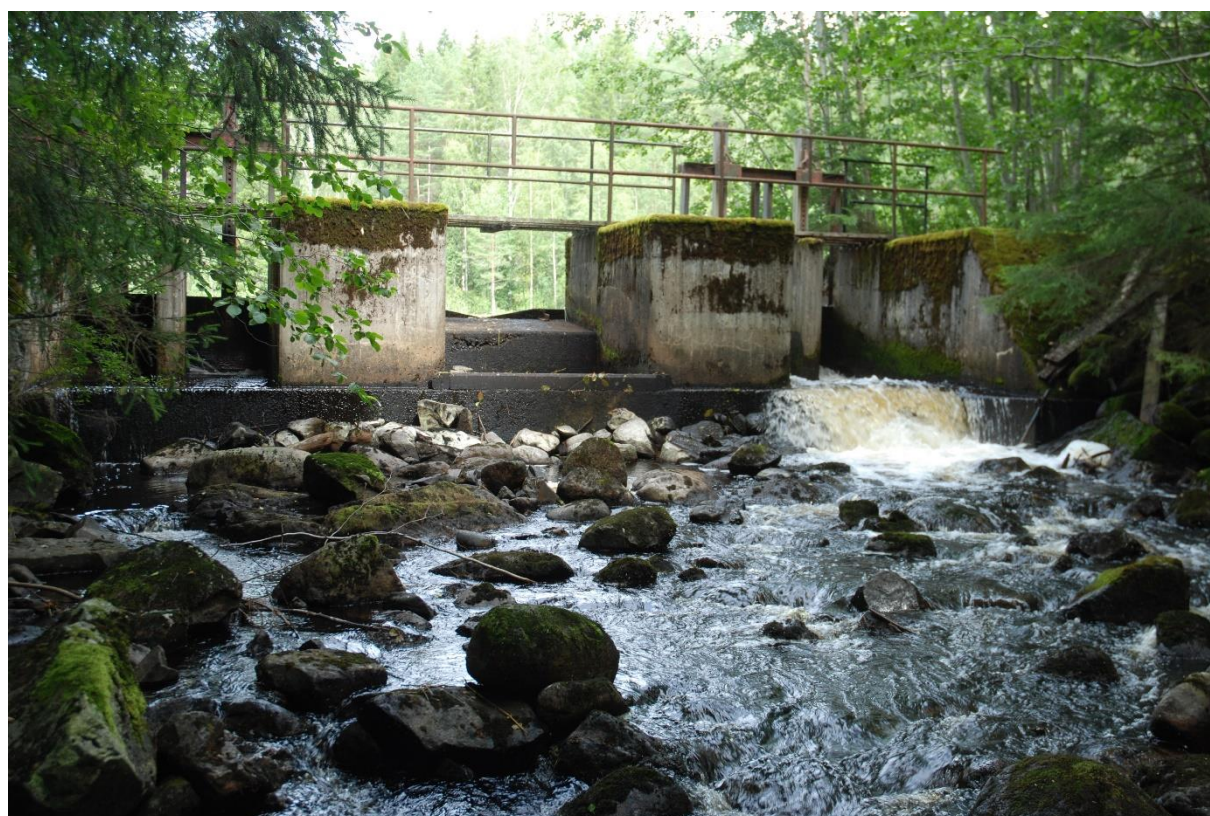
Bild nr 18: Utskovet vid Lilla Bredsjödammen 20150803. Vattenståndet var mycket lågt. Två spettluckor hade öppnats för att tillgodose flödet i Grönälven.
