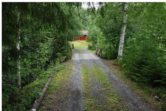
Bild nr 30: Dammvallen med broarna över de två utskoven.
