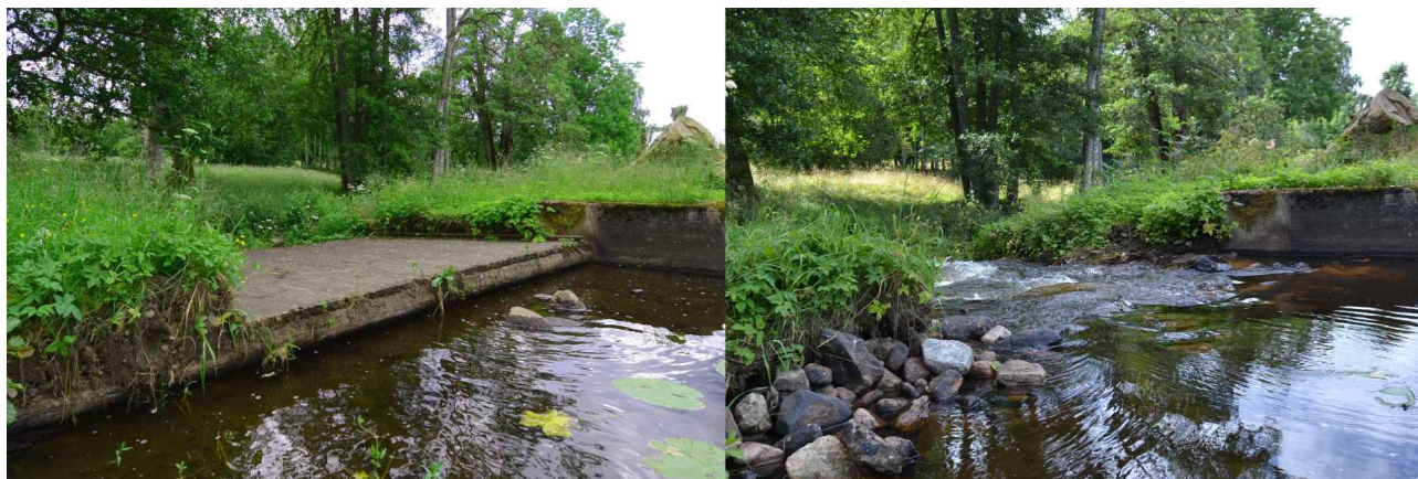
Figur 9. Före och efter åtgärd vid Mölarps kvarn, vy nedströms från dammen ned i omlöpet.
