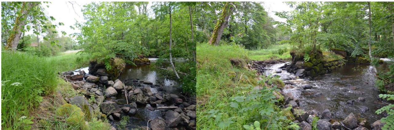
Figur 6. Dammen vid Mölarps såg före och efter åtgärd 1 juli 2015.
