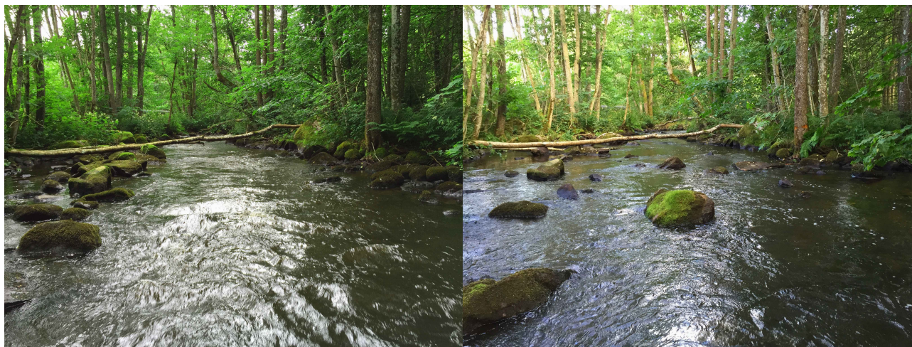
Figur 4. Före- och efterbild på en åtgärdad sträcka i norra fåran uppströms Mölarps kvarn. Vattendraget kan nu breda ut sig och vattenhastigheten har minskat.
