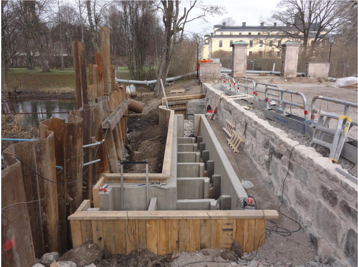
Under konstruktion och uppbyggnad
