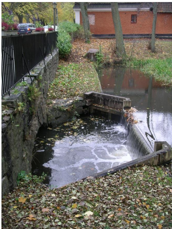
Bild före: Ulriksdalsdammen mellan havet och Igelbäcken innan fiskvägen byggdes, vandringshindrets höjd är avhängt vattennivån i Edsviken, 0,3-1,3 meter.
