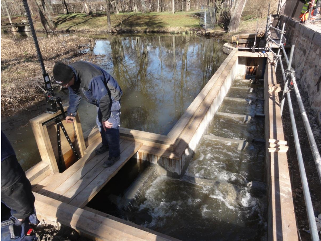
Testkörning och justering av flöden och nivåer
