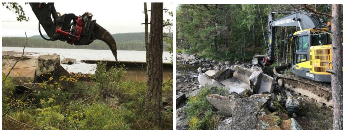
Figur 2 Under utrivningsfasen, september 2018. (Foto: Sara Sandberg)
