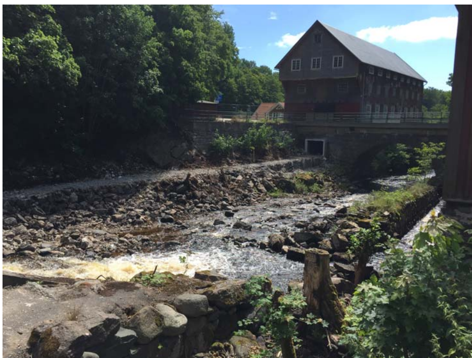
Figur 2. Den tidigare torrfåran har inte påverkats av arbetena och intagskanalen till kraftverket har rivits bort.
