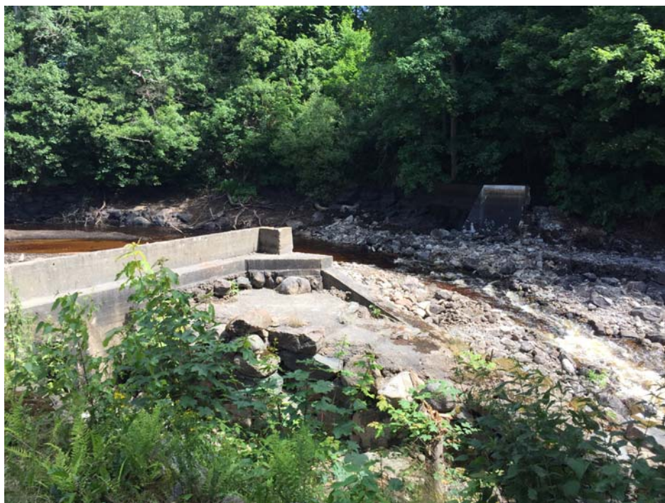
Figur 1. Utriven dammbyggnad och bevarat dammfundament invid västra strand samt ny stentröskel och stigränna. Vy från västra strand.
