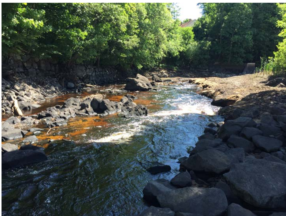
Figur 3. Åfåran direkt uppströms dammbyggnaden har ett fall på ca 2 % och består övervägande av block, sten och berg i dagen.
