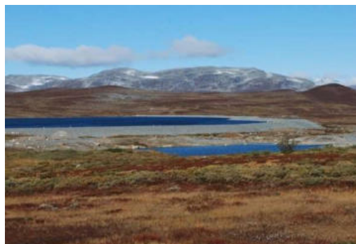
Gruvdammen på Stekenjokkplatån.
