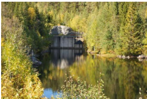
Utloppet från kraftverket.
