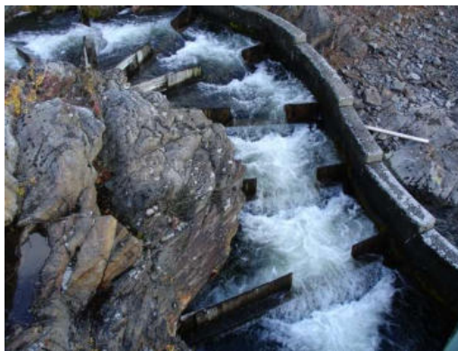
Fiskvägen vid det södra utskovet.
