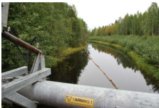
Grävda kanalen och inloppet till tunneln som leder Högforsåns vatten ned till Högfors kraftverk.
