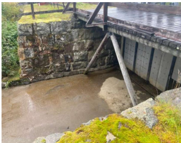
Utskovet på västra sidan av regleringsdammen.
