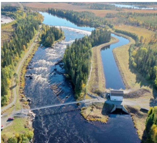
Översiktsbild över anläggningen vid Gubbseleforsen.
