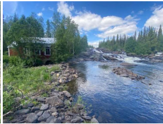
Kraftverket vid sidan om naturfåran.
