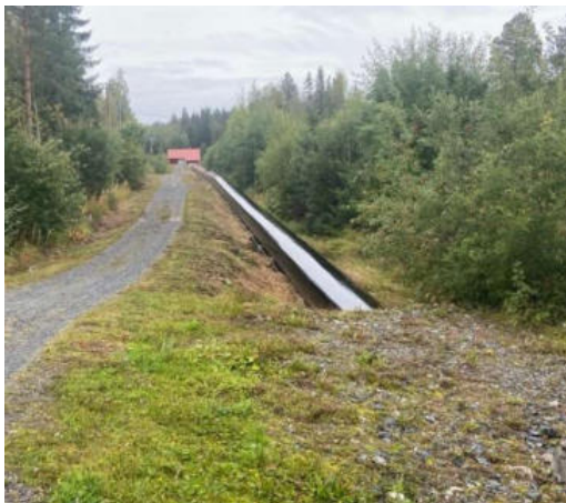
Tuben som leder Bruksåns vatten ned till kraftverket.
