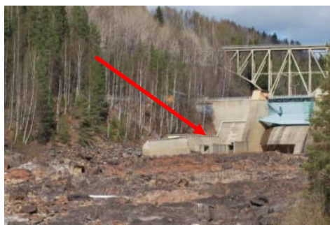
Betongstommen kvar vid fiskhissen.
