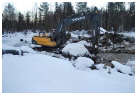
Grävarbetet började julen 2015.
