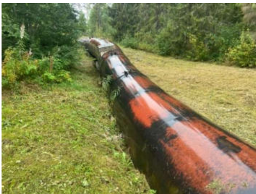
Bruksåns vatten går via en tub från regleringsdammen ned till kraftverket.
