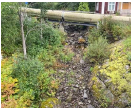
Bruksåns vatten går via en tub ned till kraftverket. I bilden passerar tuben den torrlagda fåran.
