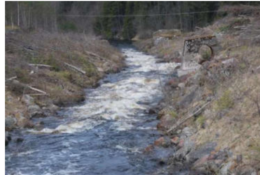
Spillfåran nedanför regleringsdammen.
