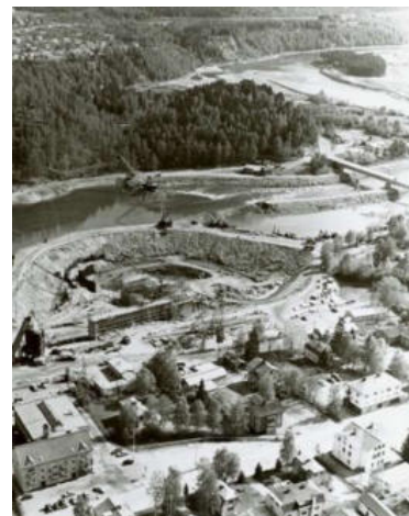
Bygget av kraftverket. (foto Murberget)
