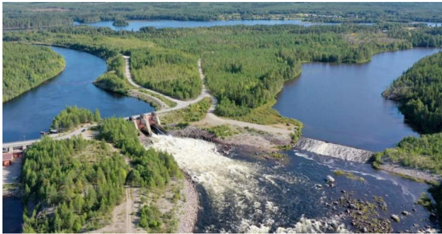
Översiktsbild över området vid Åsele kraftverk.
