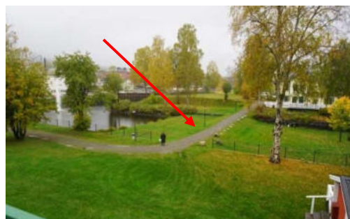
Gång- och cykelväg ovanpå dammvallen.
