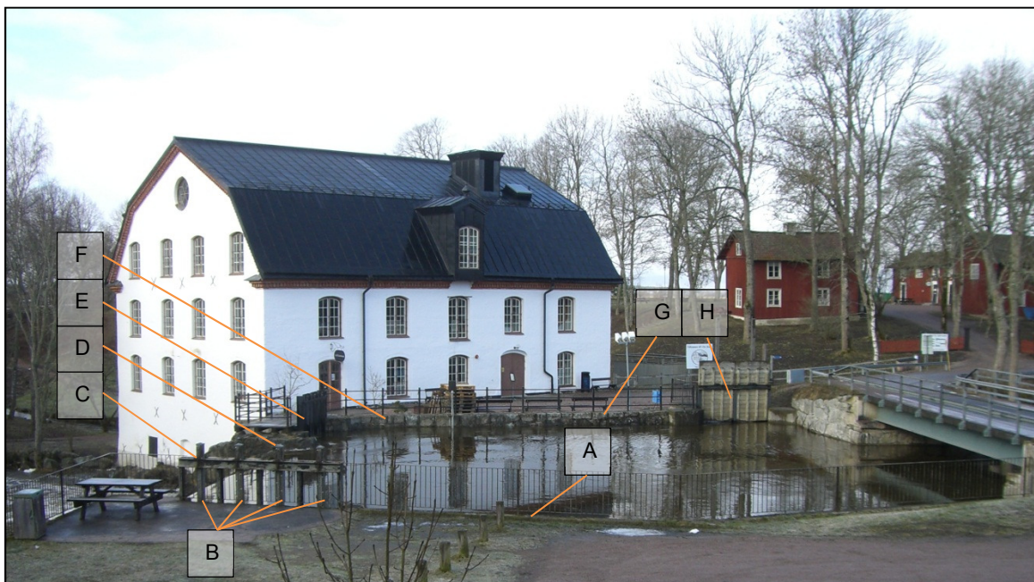
Figur 3a. Befintliga anläggningsdelar vid Ulva kvarndamm, fotograferad från dammens östra sida.
