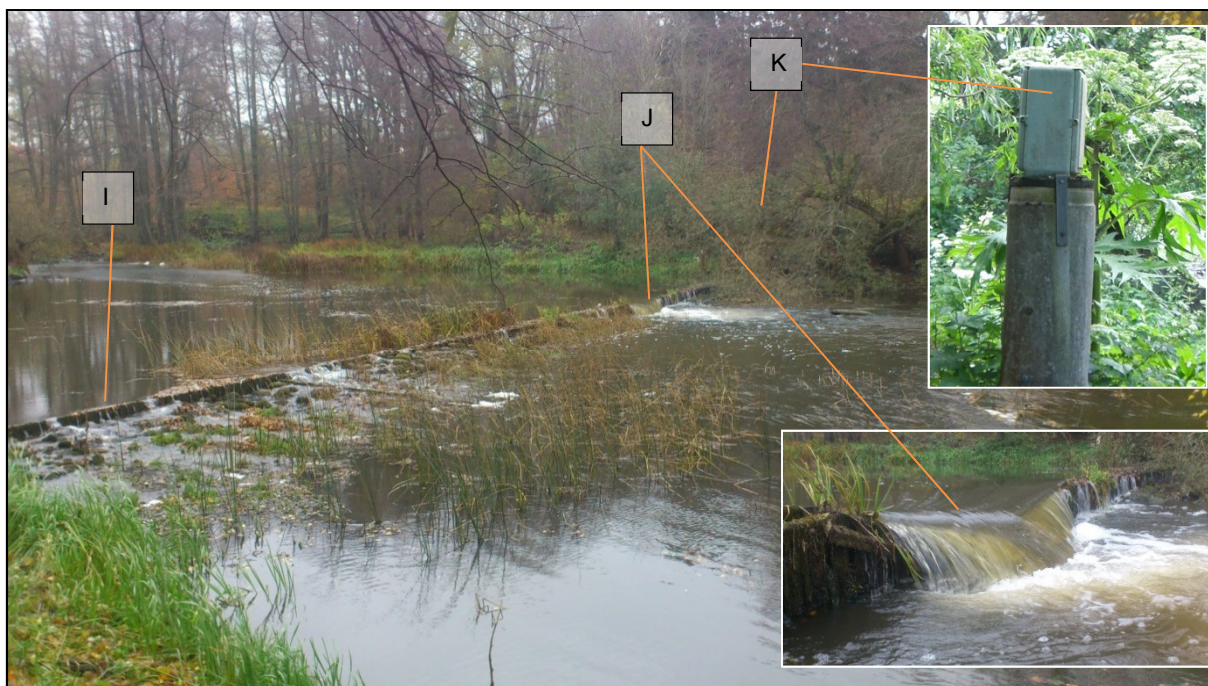
Figur 3c. Befintliga anläggningsdelar vid mätdammen nedströms Ulva kvarn, fotograferad från västra stranden vid lågvattenföring.
