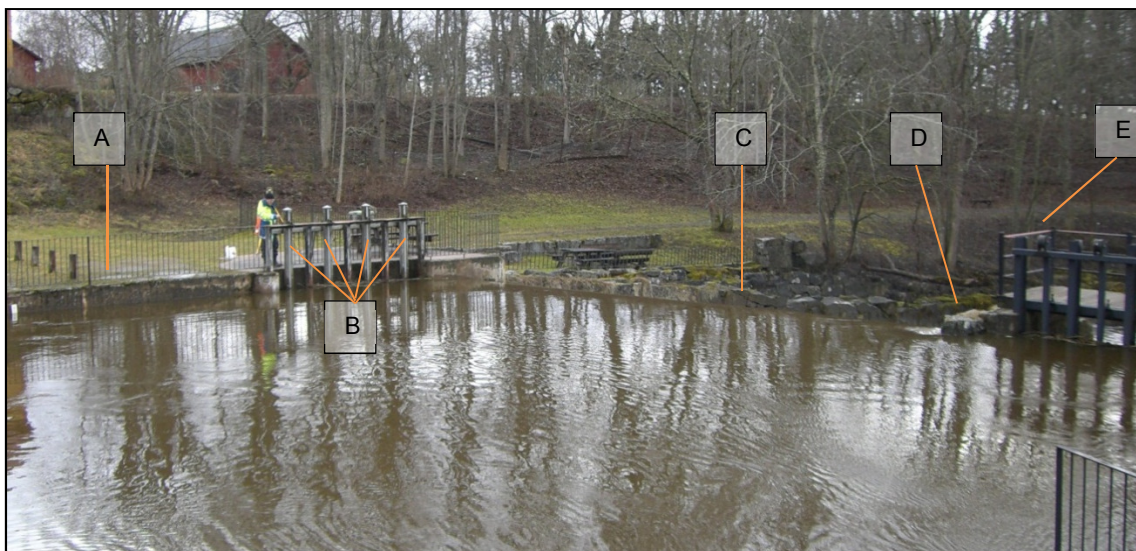
Figur 3b. Befintliga anläggningsdelar vid Ulva kvarndamm, fotograferad från dammens nordvästra sida.
