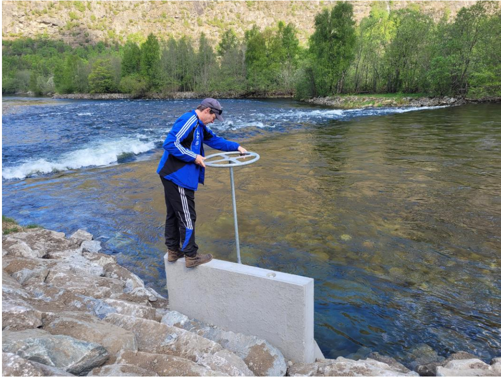
Svinghjul benyttes til å justere luken i vingemuren for å tilpasse vannføringen i Grøttekilen.
