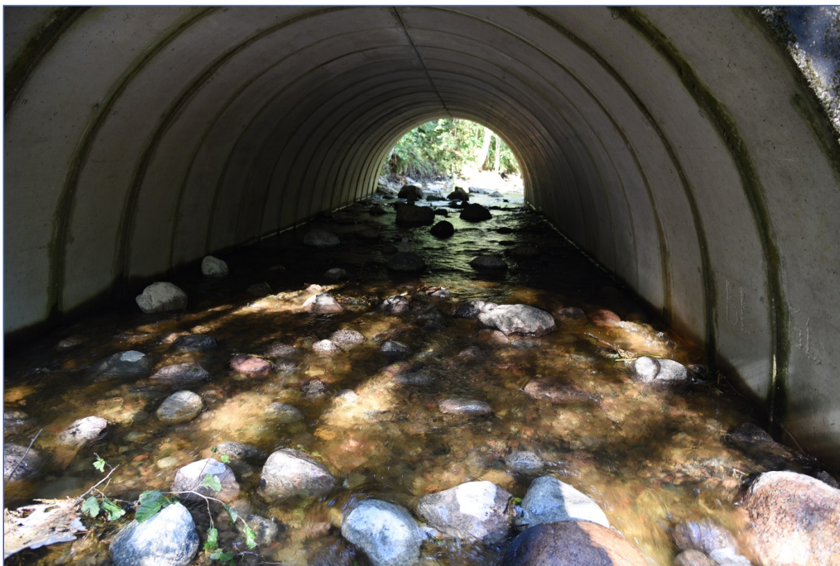
Figur nr 9: Trumman efter åtgärd.
