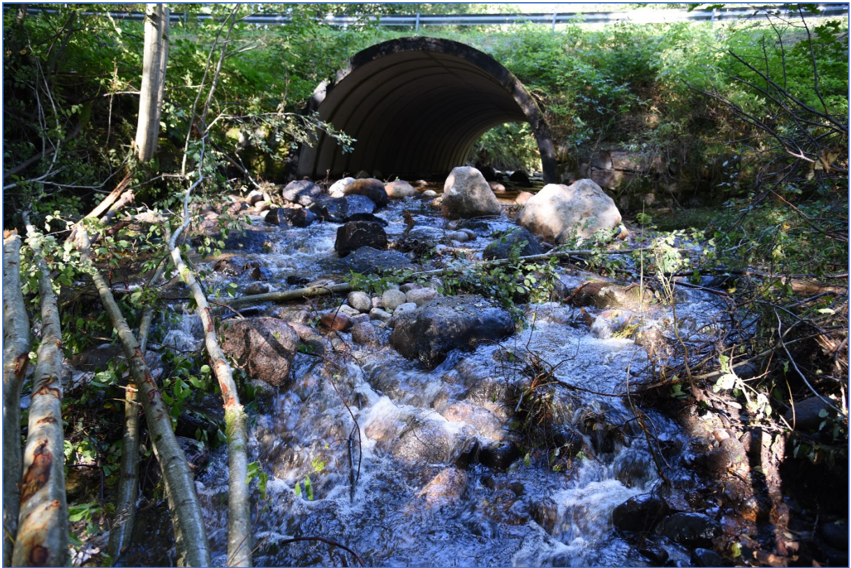
Figur nr 7: Nedströmssidan av trumman efter åtgärd.
