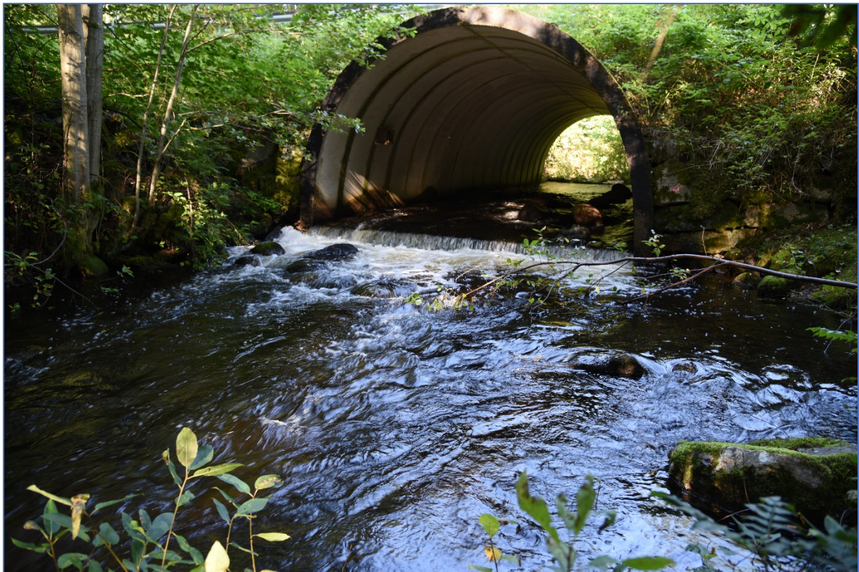
Figur nr 6: Nedströmssidan av trumman före åtgärd.
