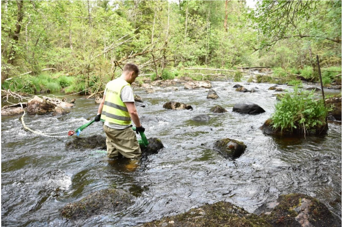
Figur 1. Restaurering av Tattarströmmarna, Häggån. Ett krävande arbete då ån är bred.
