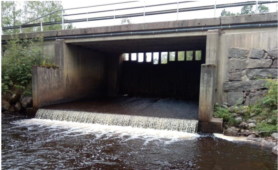
Bild på regleringsdammen tagen i augusti 2019.
