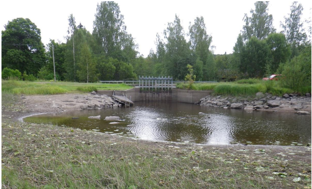
Bilden visar regleringsdammen i samband med låg vattenföring i Gimmaån i augusti 2016.
