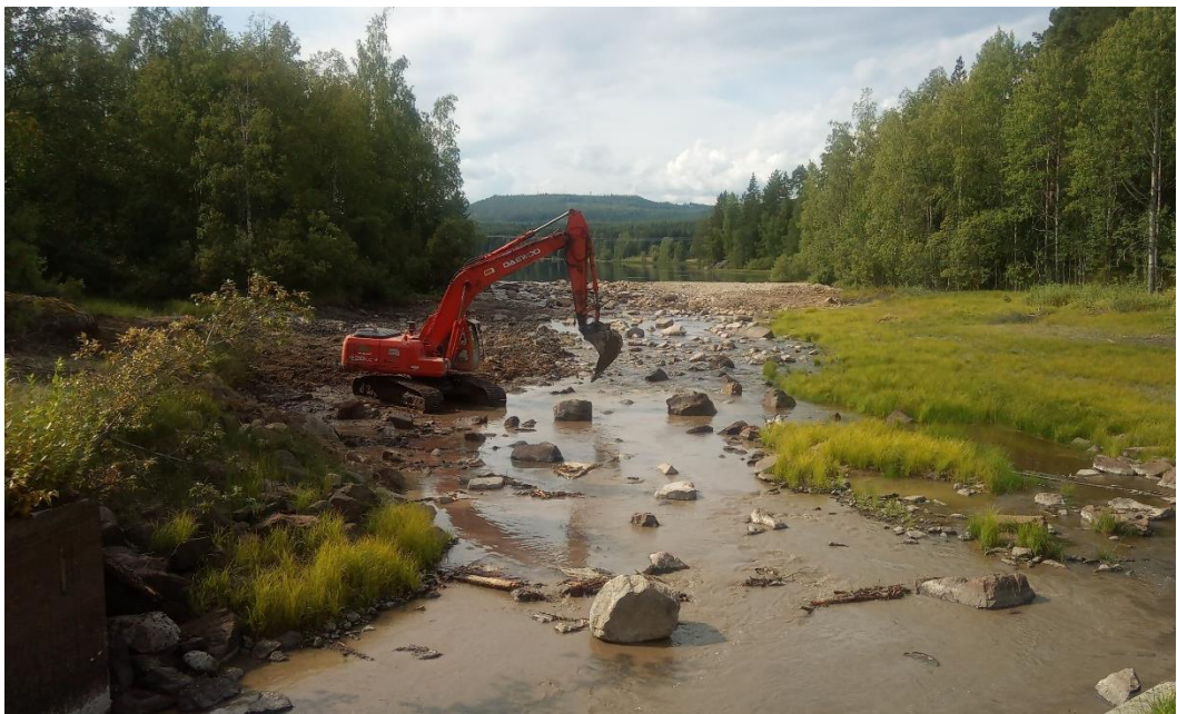
Sjöträskeln anlades i samband med låg vattenföring i Gimmaån. Bild från augusti 2020.
