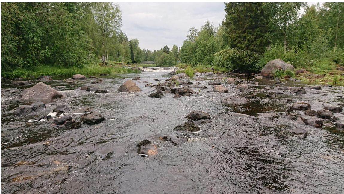
Figur 11: Nedre delen av Ytterstforsen efter återställning där stenmaterial från stränderna samt från fåran har använts för att skapa strukturer och variation i älvsfåran.
