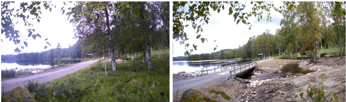
Figur 3. Dammsjödammen före och efter åtgärd
