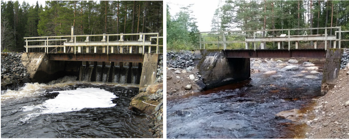
Figur 6. Gräntjärnsdammen före och efter åtgärd
